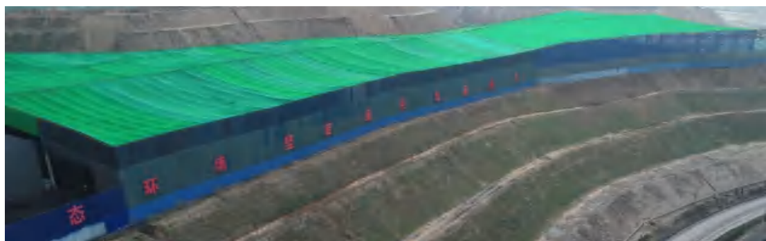
照片 3-19 储煤场内临时储煤棚
