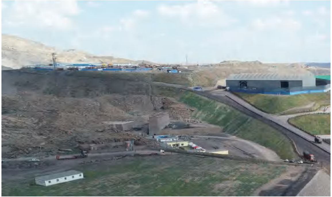
照片 2-10 东辰外排土场北侧边坡固化及绿化效果
