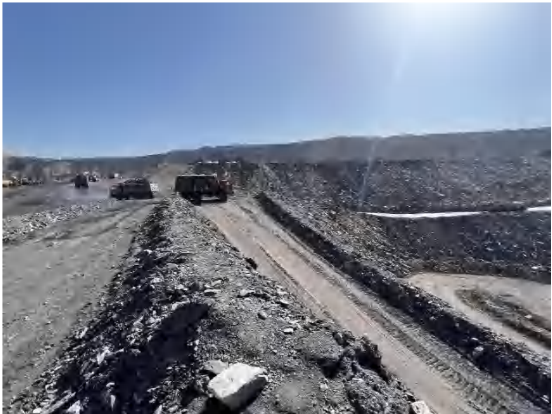
照片 3-8 内排土场北段全貌
