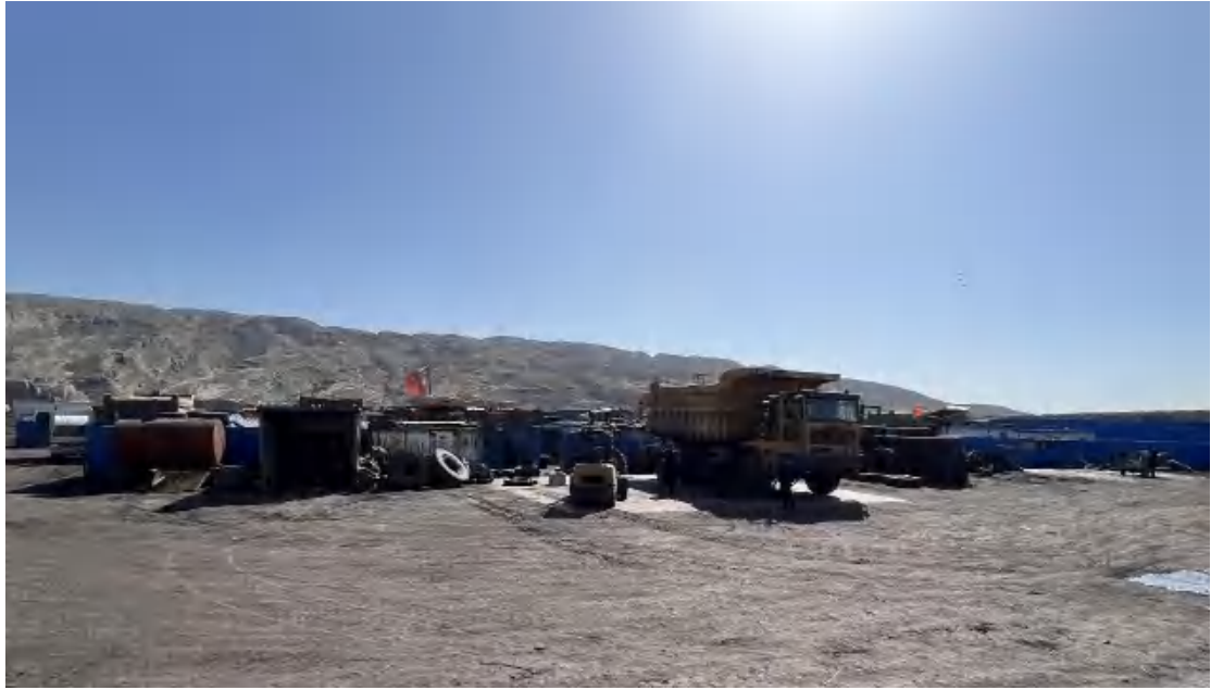
照片 1-8 施工队生活区
