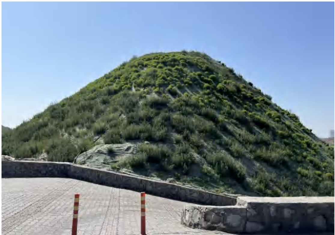
照片 2-24 六保煤矿边坡恢复的植被
