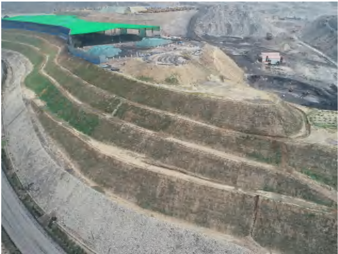
照片 1-4 外排土场南端六保煤矿西外排土场
