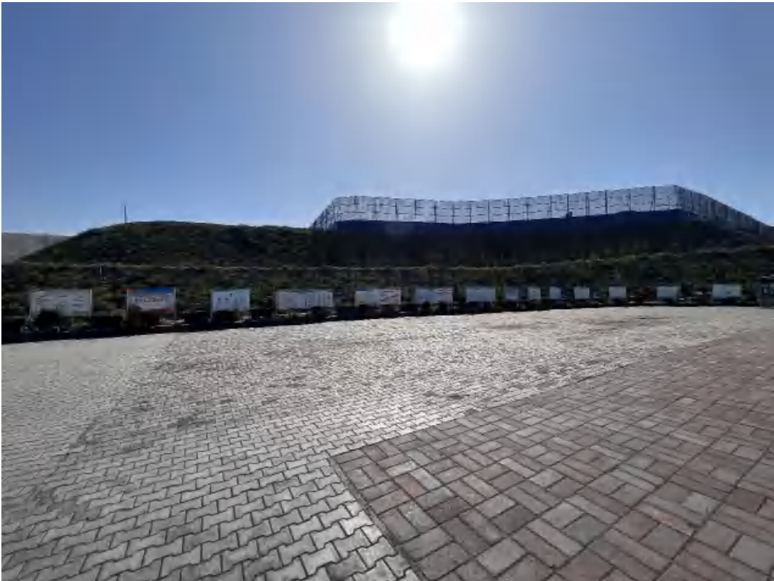
照片 3-13 外排土场西侧上部边坡
