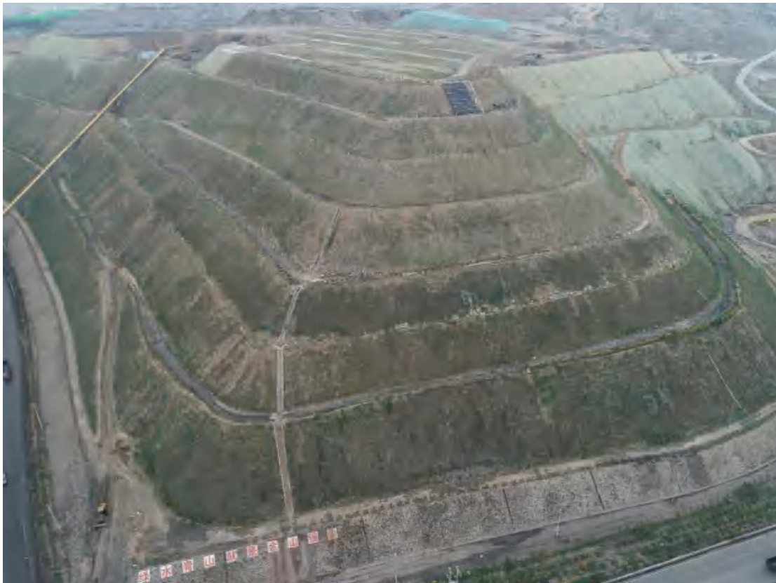
照片 2-18 六保煤矿东外排土场边坡治理效果
