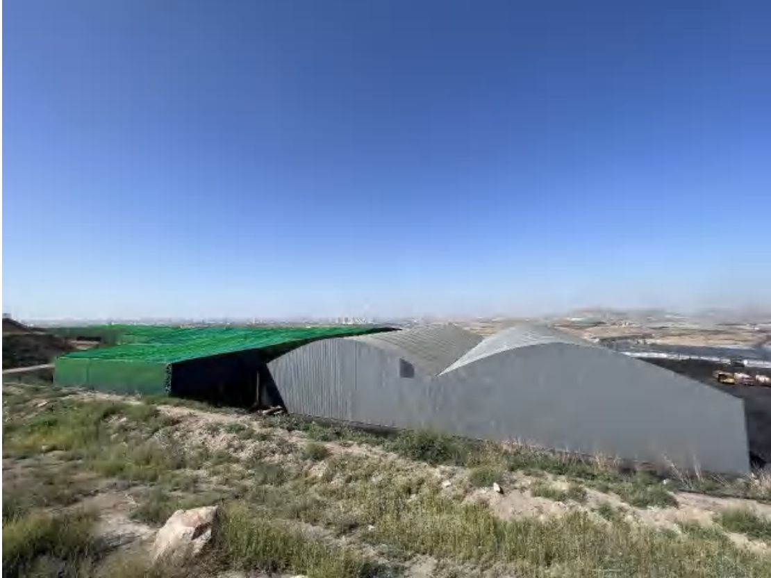
照片 1-7 储煤棚及临时储煤棚
