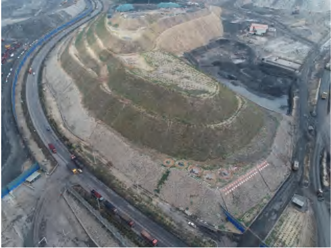
照片 2-19 六保煤矿西外排土场边坡治理效果
