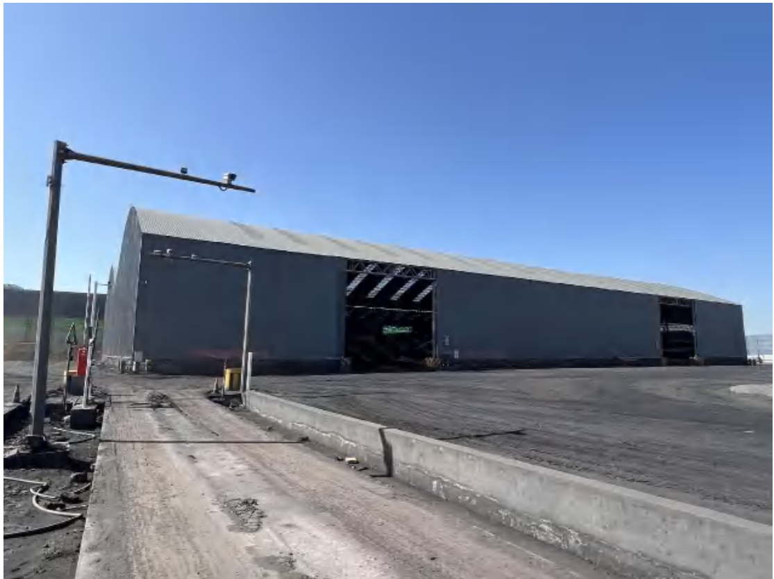
照片 2-11 钢结构储煤棚
