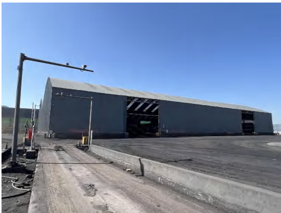
照片 3-18 储煤场内钢结构储煤棚
