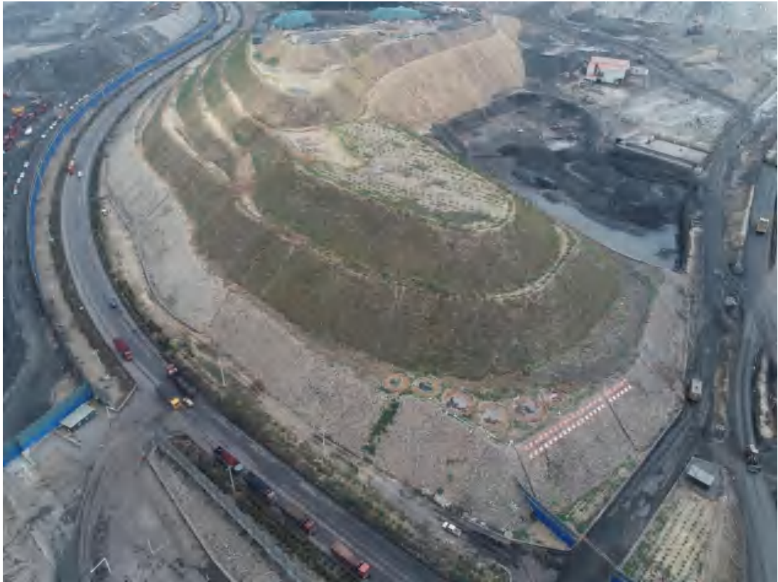
照片 3-10 外排土场南端六保煤矿西外排土场
