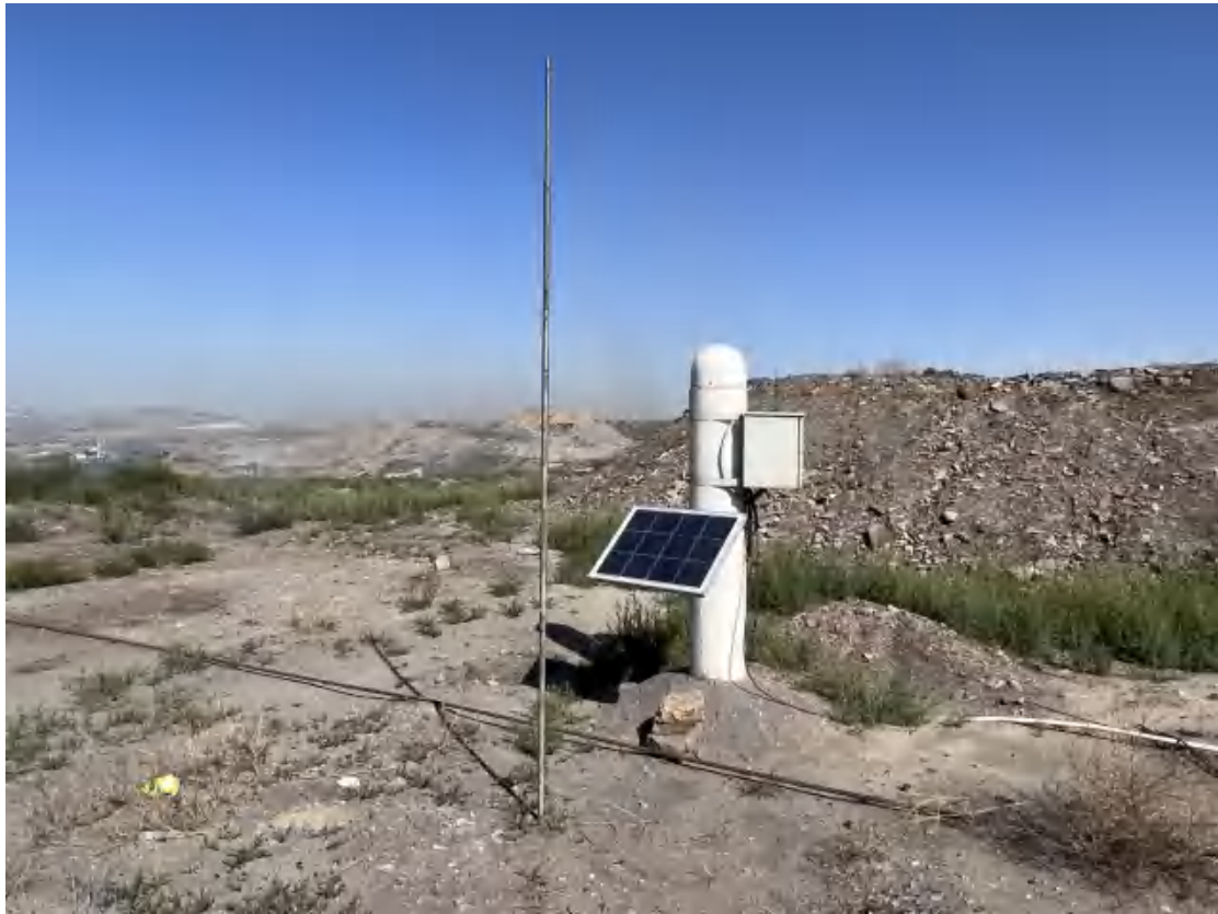
照片 2-7 东辰煤矿边坡监测点
