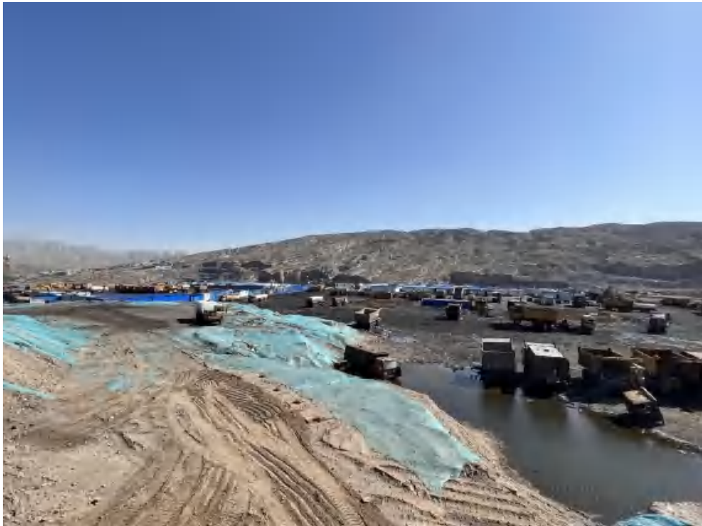
照片 3-17 施工队生活区全貌
