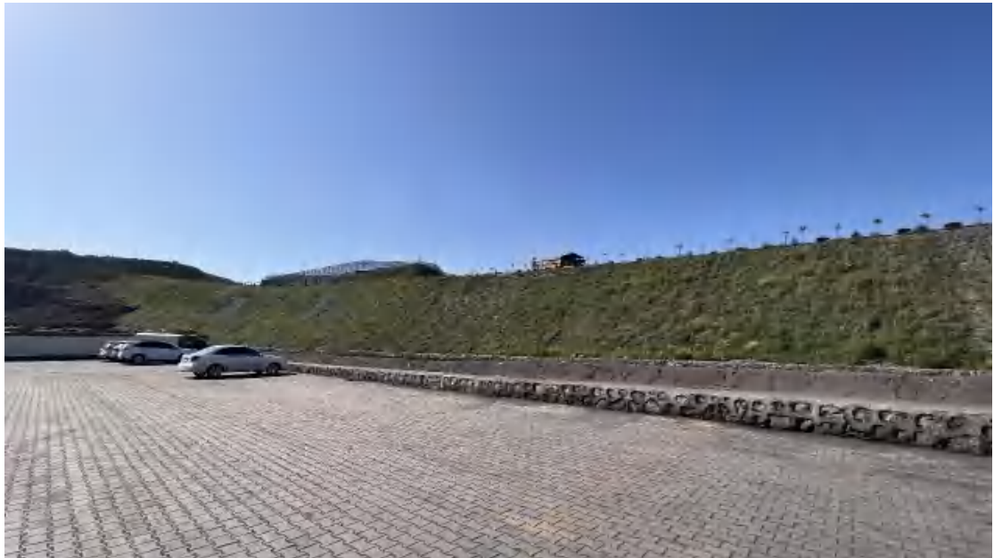
照片 2-9 外排土场北侧边坡治理效果
