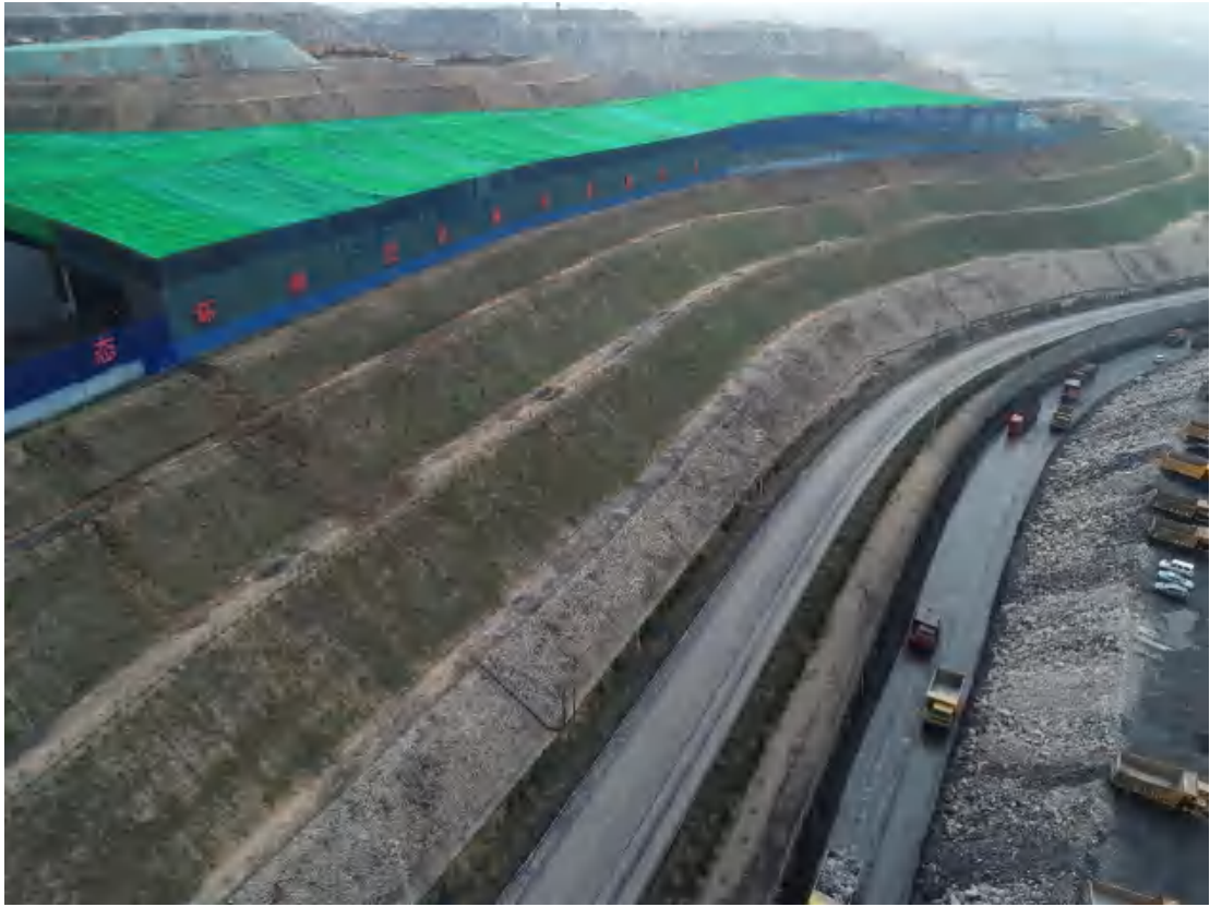
照片 1-3 外排土场
