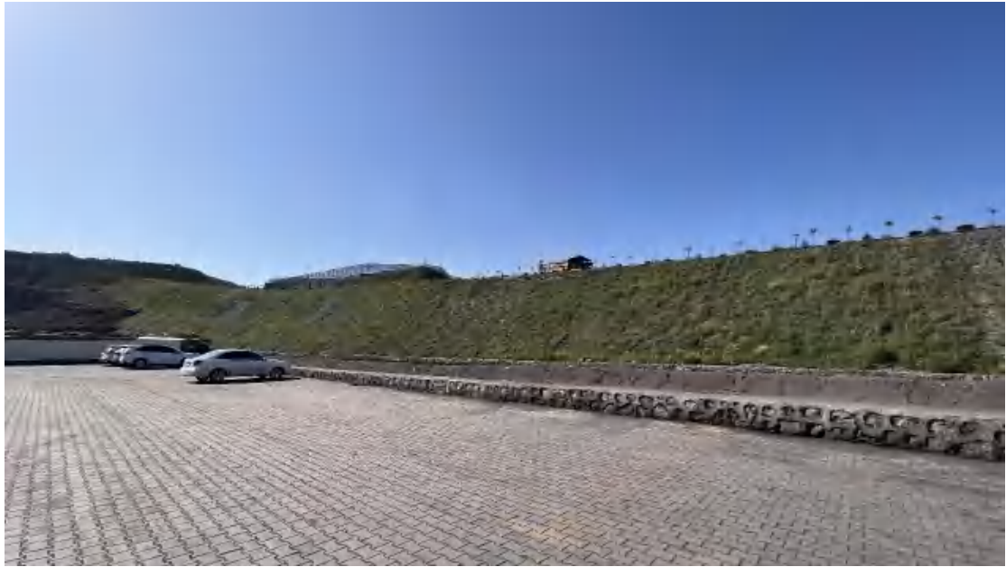
照片 3-14 外排土场北侧边坡
