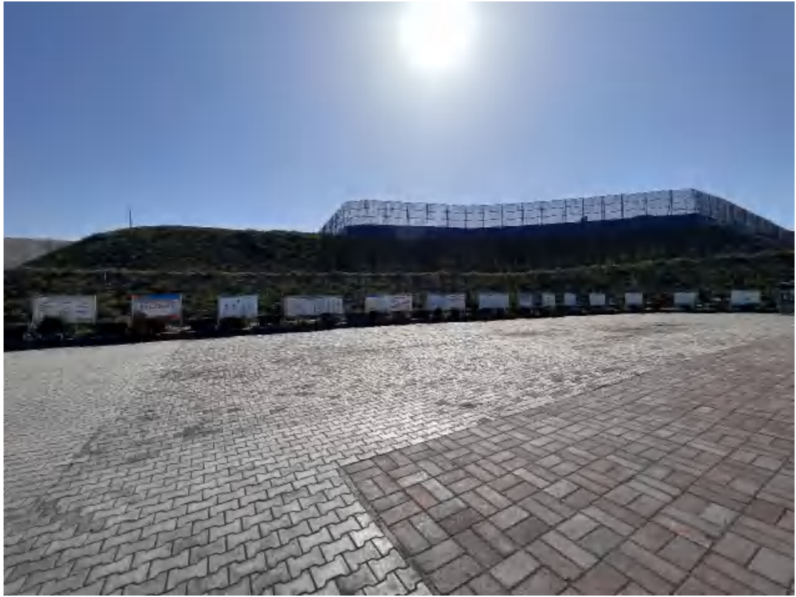
照片 2-8 外排土场西侧上部边坡治理效果
