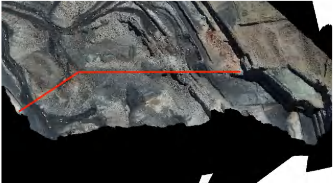
照片 3-26 矿区南侧涉嫌违法用地
