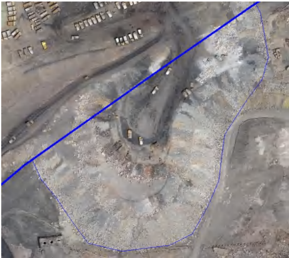
照片 3-11 外排土场南侧六保煤矿衔接区域渣堆
