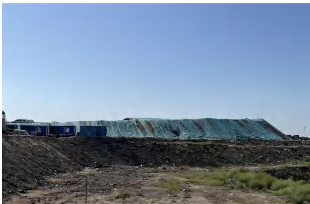
照片 3-21 表土存放堆
