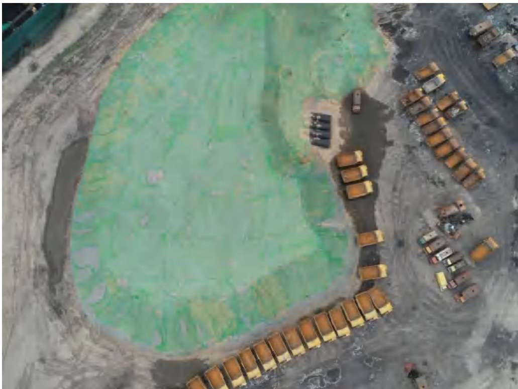
照片 1-9 表土存放堆
