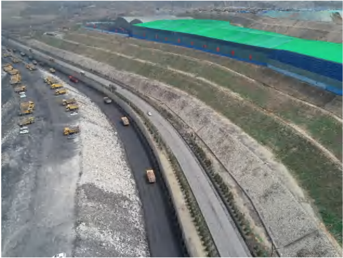
照片 2-6 外排土场西侧边坡治理效果
