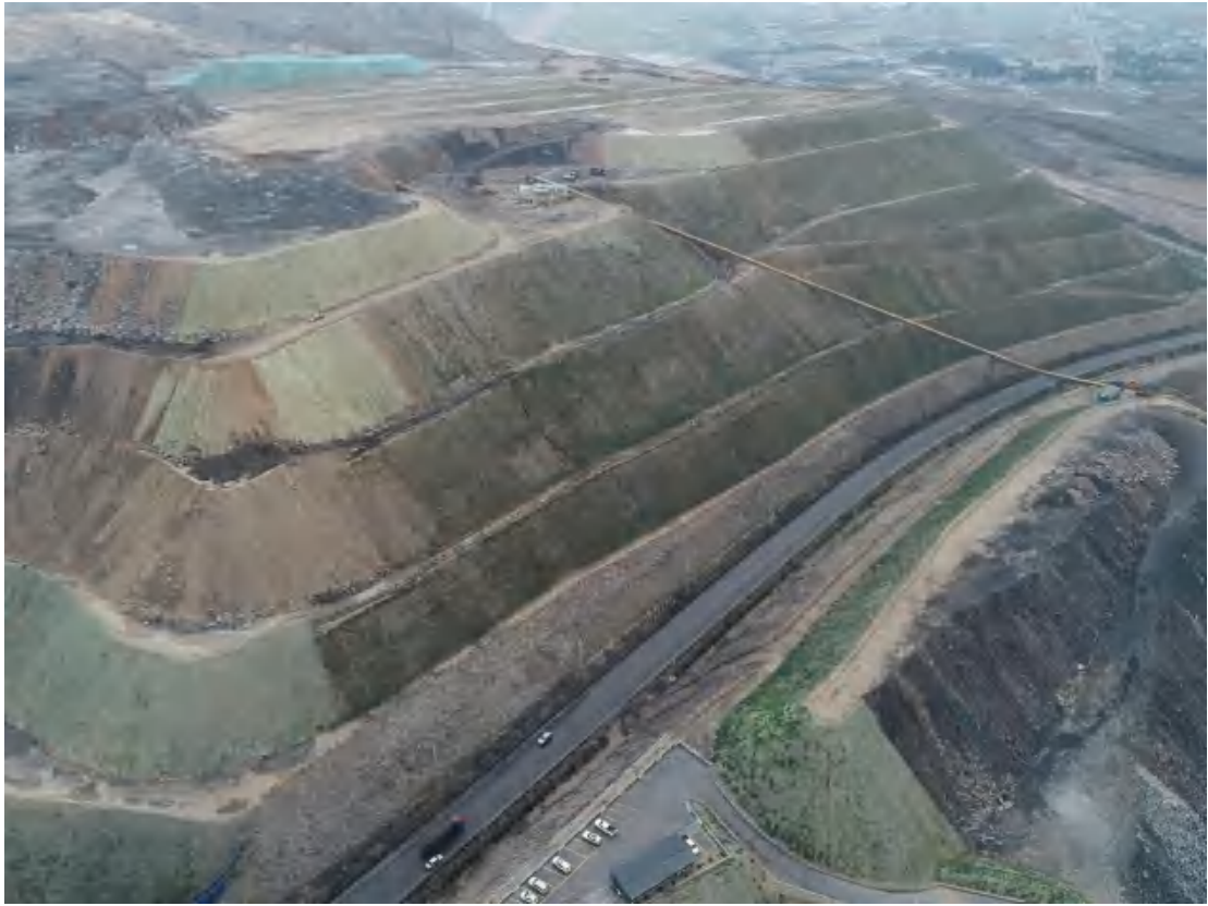
照片 2-25 六保煤矿东外排土场边坡治理效果
