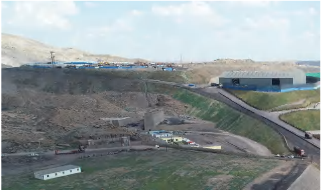
照片 3-8 东辰外排土场北侧边坡固化及绿化
