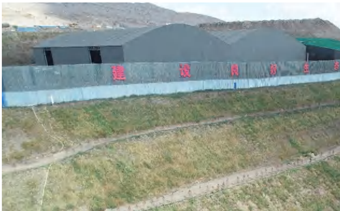
照片 3-12 储煤场内钢结构储煤棚
