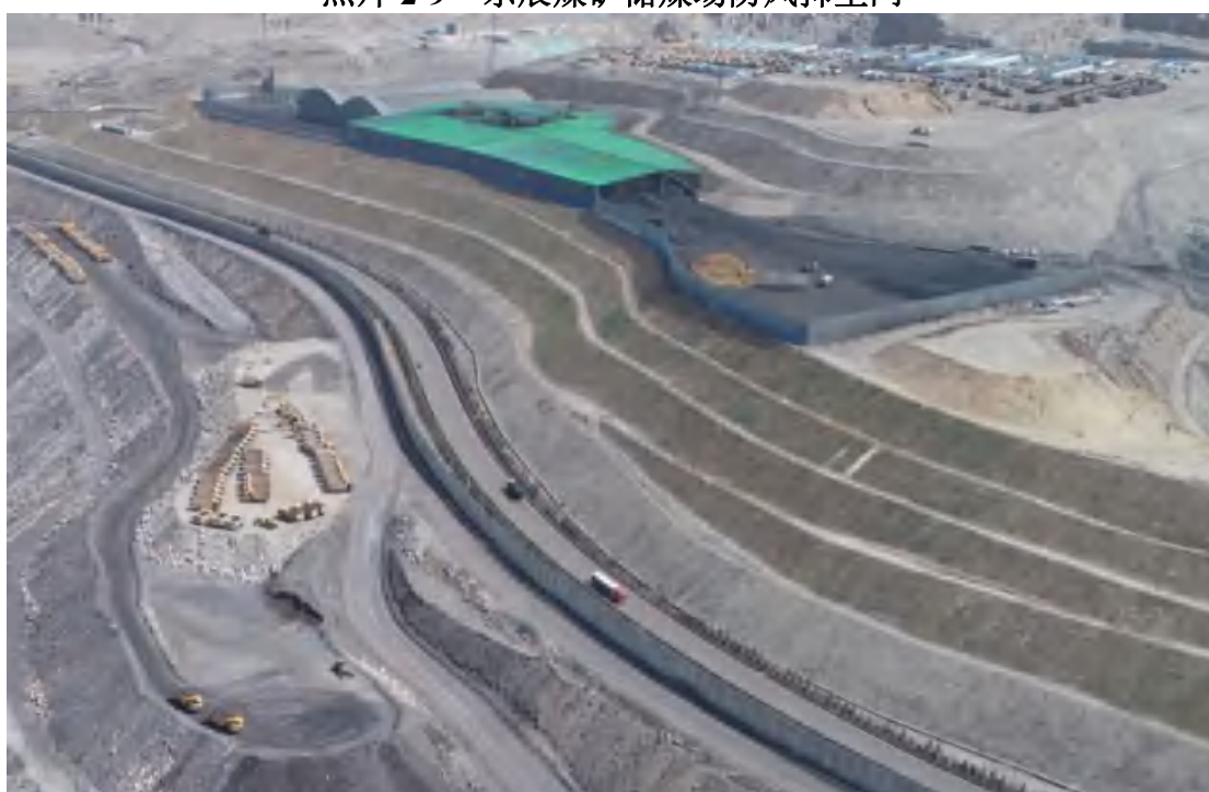
照片 2-10 东辰煤矿外排土场边坡固化及绿化
