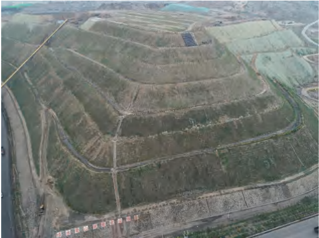
照片 2-7 东外排土场南侧边坡及顶部治理后全貌
