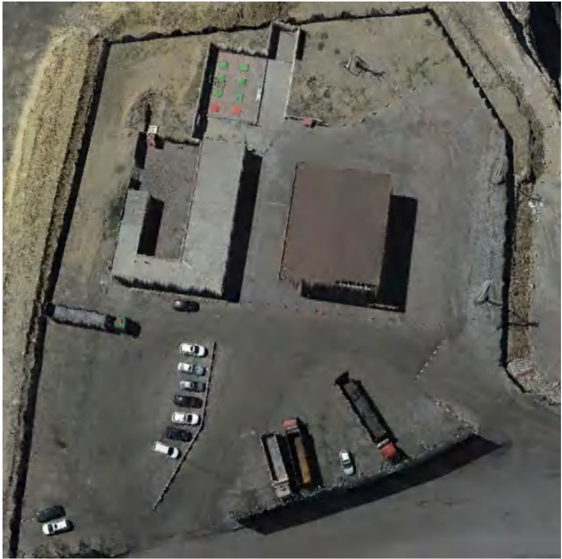
照片 1-16 加油站全貌
