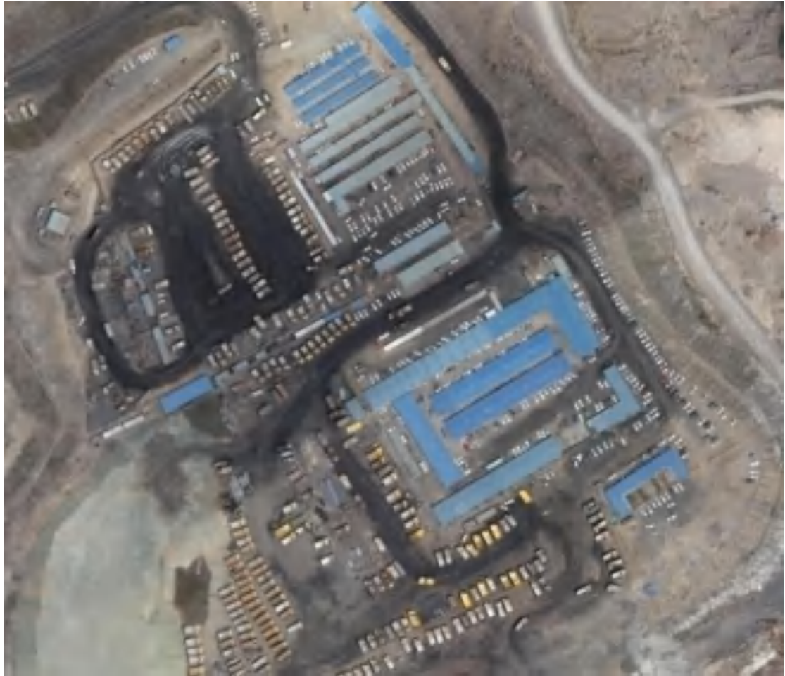
照片 3-17 施工队生活区正射全貌
