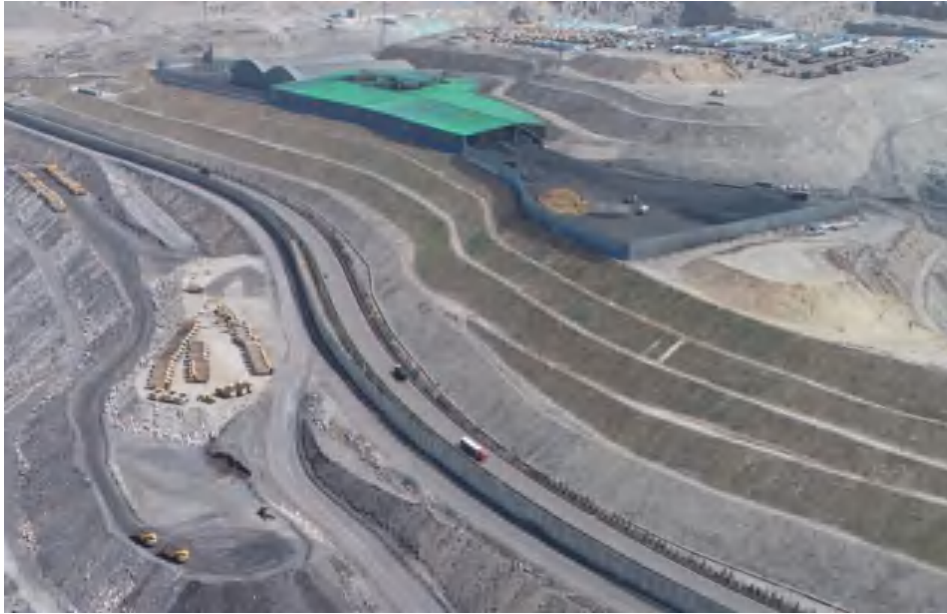
照片 1-8 东辰外排土场固化及绿化
