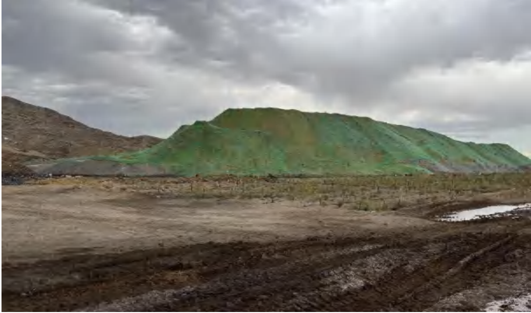
照片 3-10 表土存放堆
