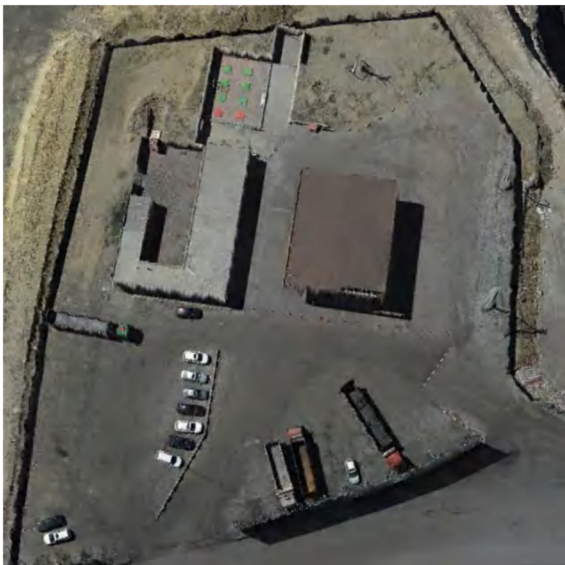
照片 3-16 加油站全貌
