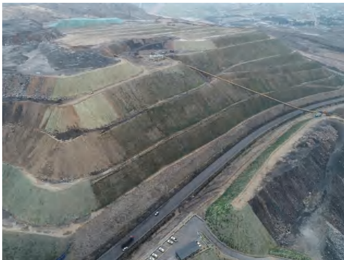
照片 2-6 东外排土场西侧边坡治理后全貌
