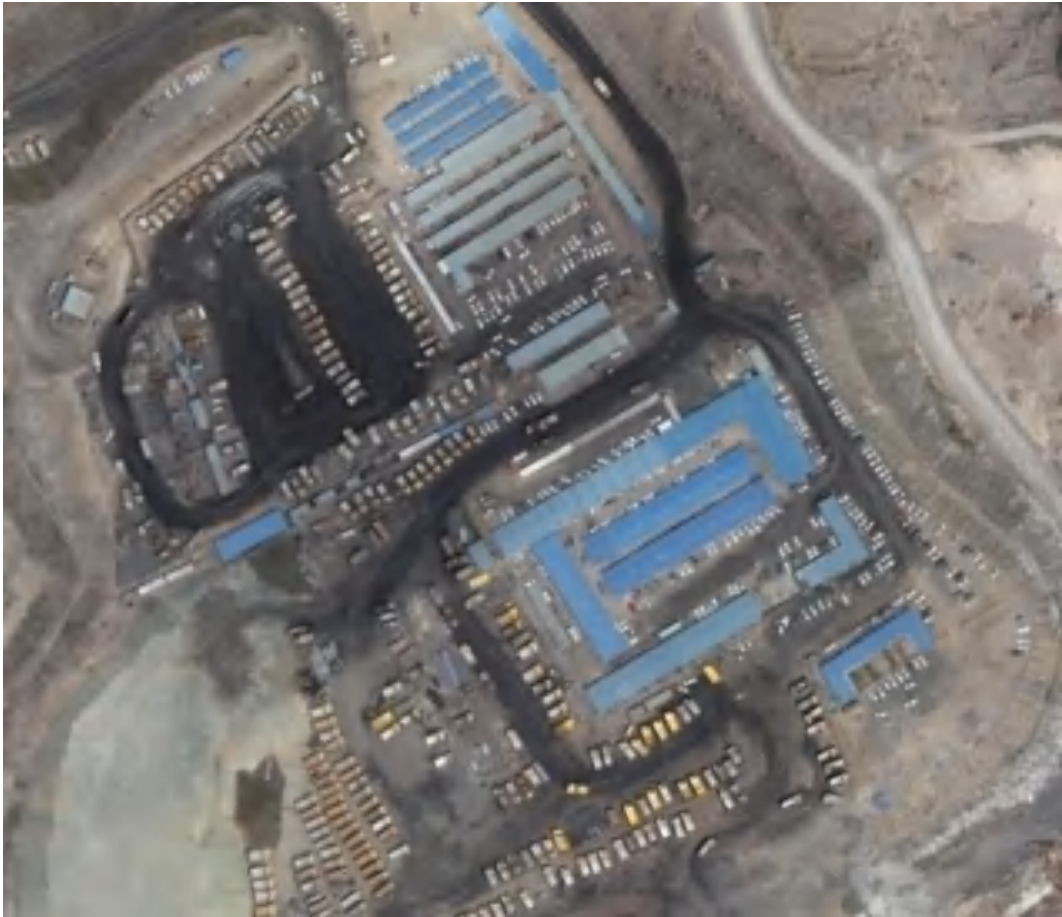
照片 1-17 施工队生活区正射全貌
