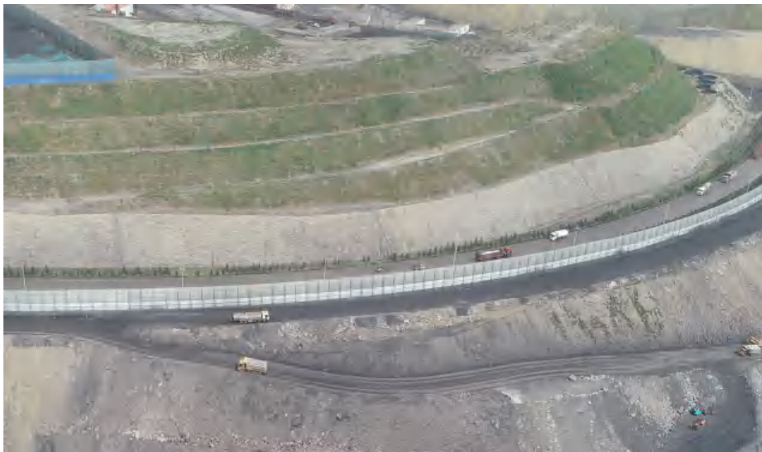
照片 2-8 北外排土场边坡治理后全貌
