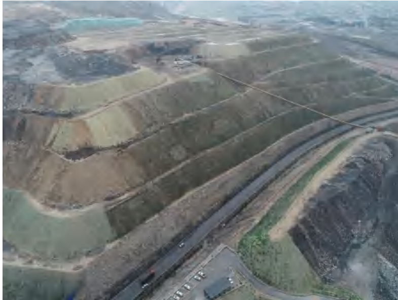
照片 3-3 东外排土场西侧边坡治理后全貌
