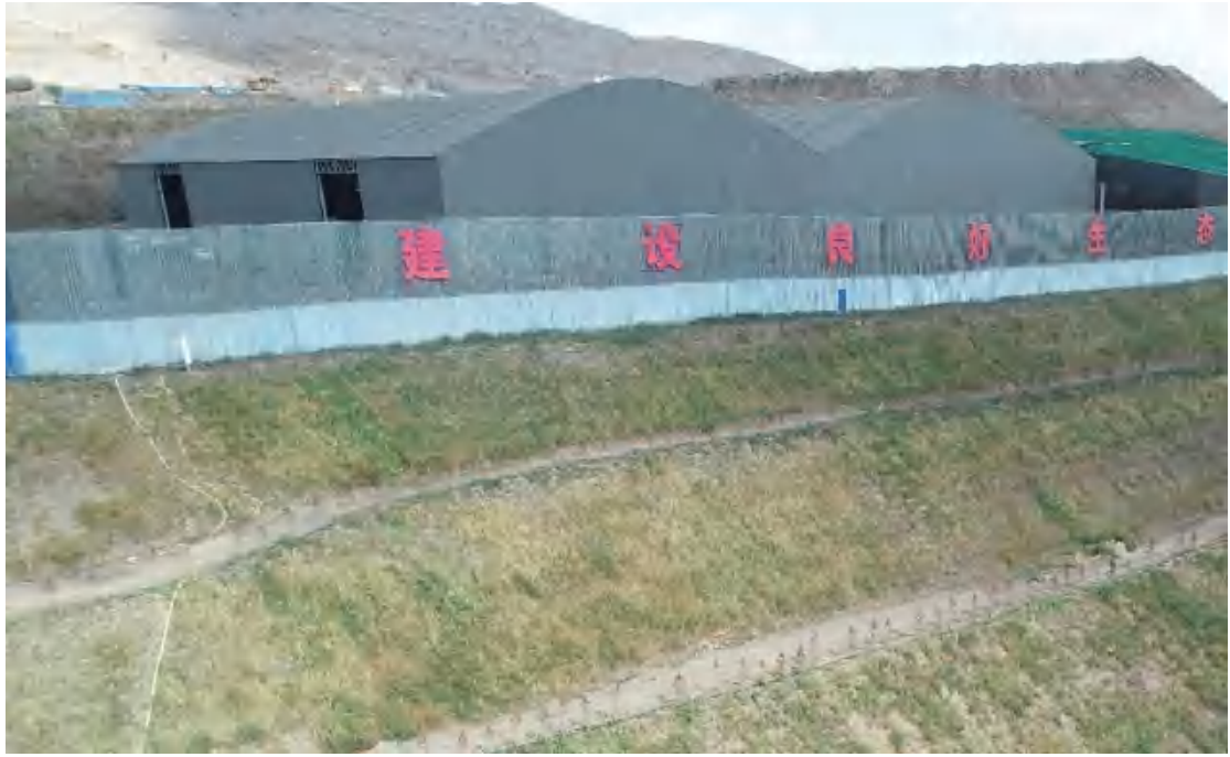
照片 1-12 储煤场内钢结构储煤棚
