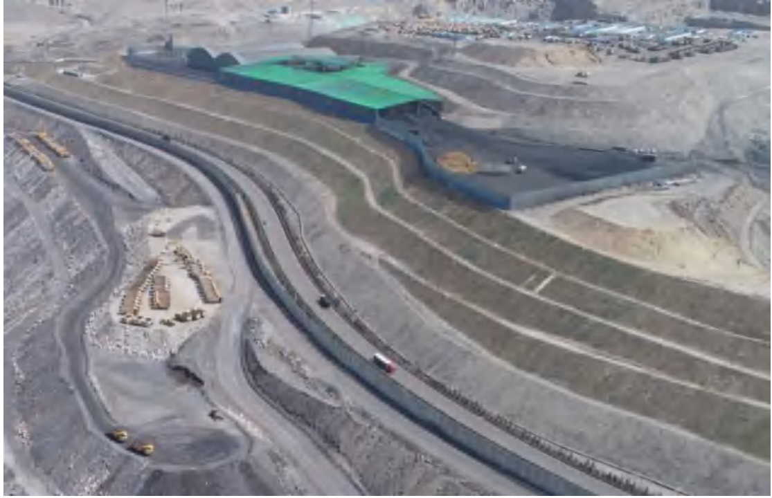
照片 3-7 东辰外排土场西侧边坡固化及绿化
