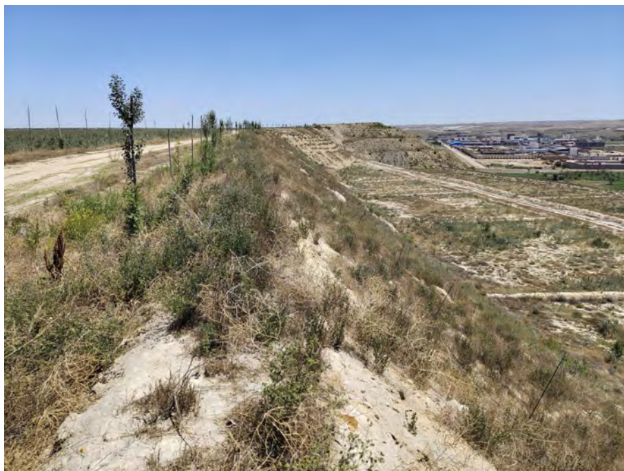
照片 3-7 内排土场已治理区（边坡复垦区）
