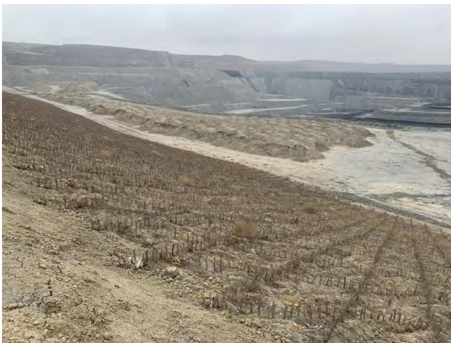
照片 3-9 2 号表土存放场
