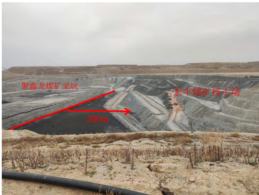
照片 3-3 现状露天采坑顶部与宏丰煤矿排土场
