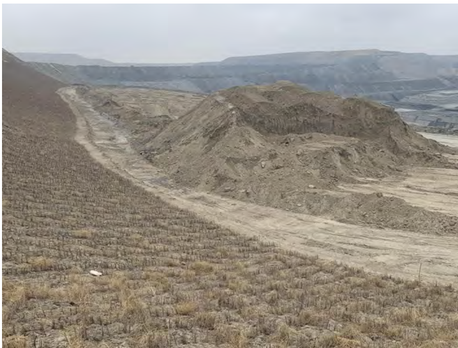
照片 3-8 1 号表土存放场
