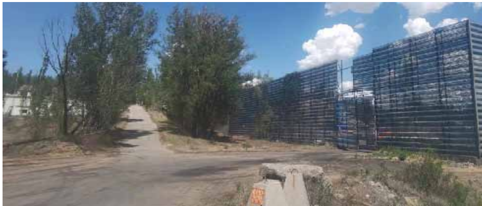
照片 1-3-5 进场道路
