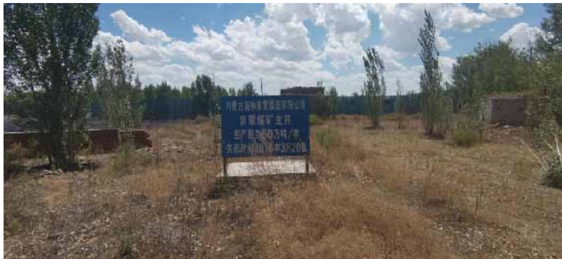
照片 1-3-8 已封堵主井
