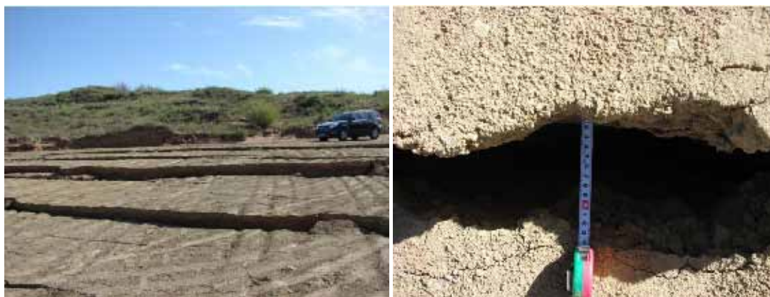
照片 2-10 上湾煤矿地面损毁情况
