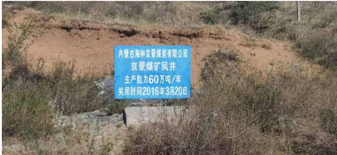
照片 1-3-7 已封堵风井
