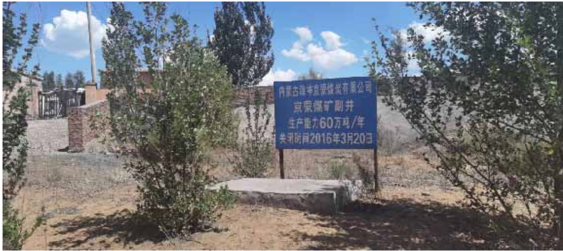
照片 3-2-6 已封堵副井
