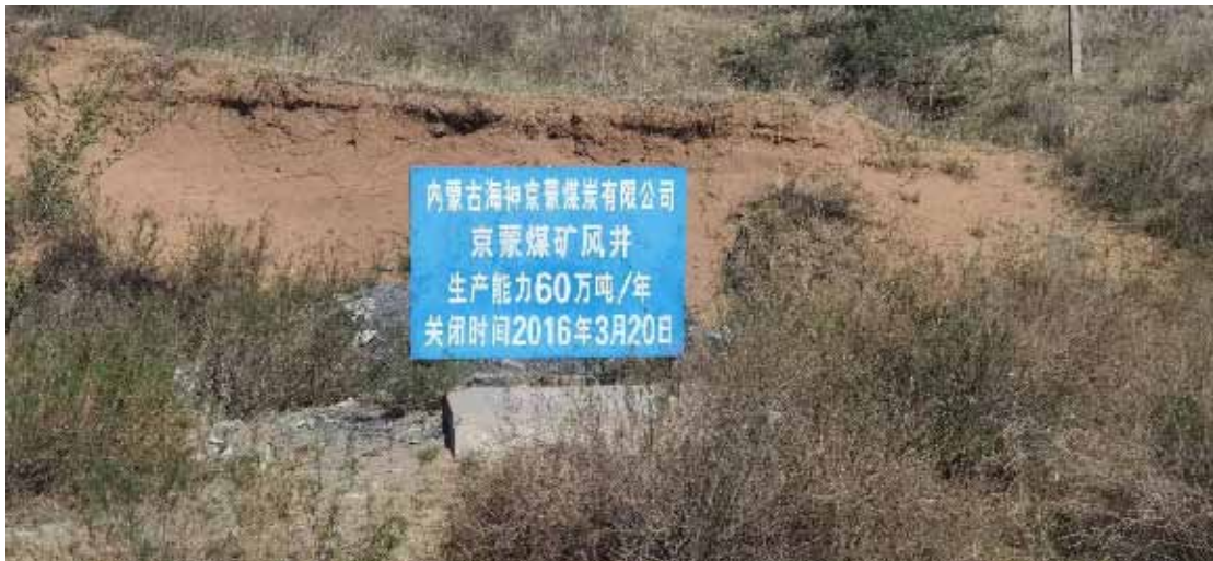
照片 2-6-2 已封堵风井
