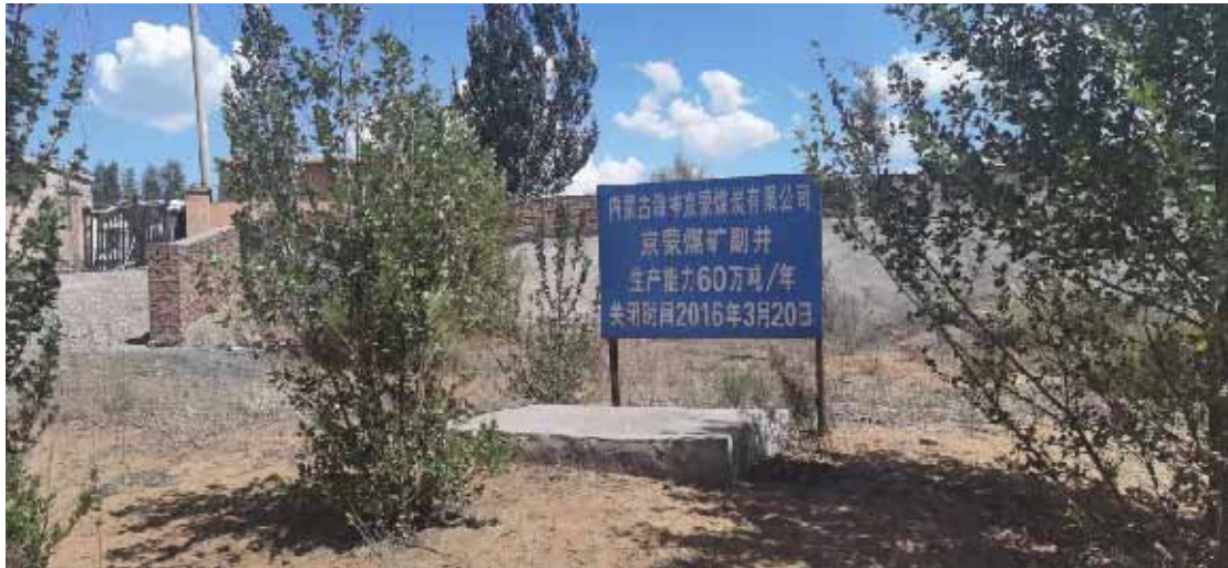
照片 1-3-6 已封堵副井
