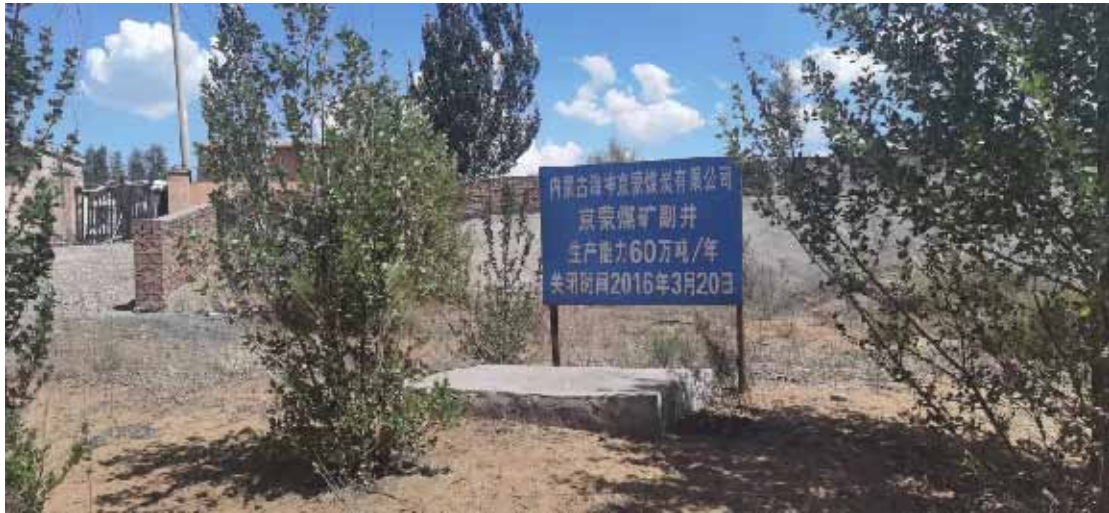
照片 2-6-1 已封堵副井
