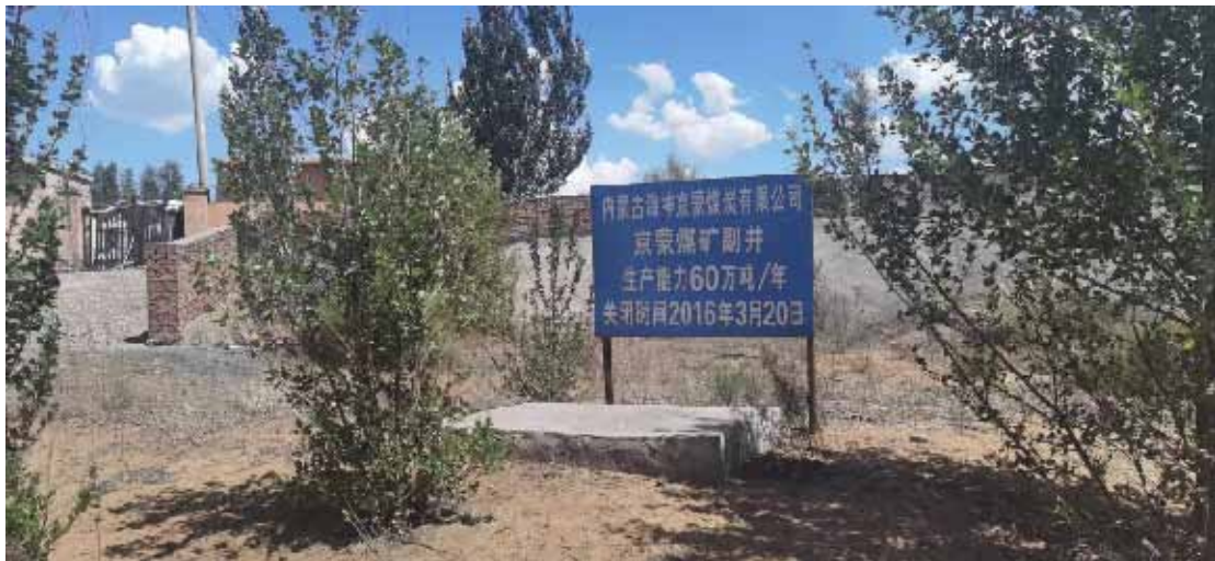
照片 1-3-6 已封堵副井
