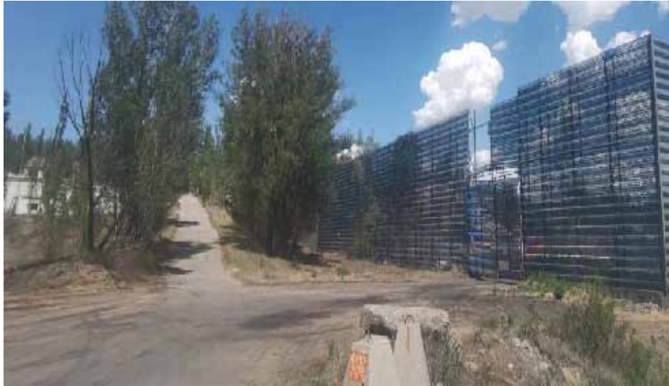
照片 1-3-5 进场道路
