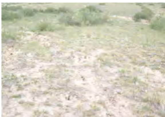
照片 2-13 回填裂缝
