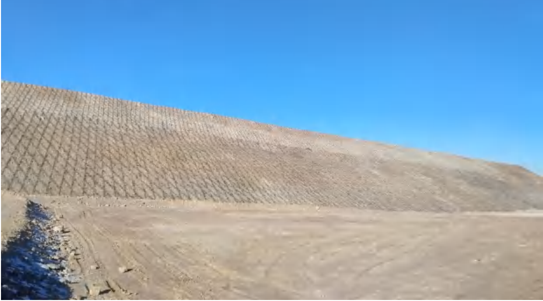
照片 1-9 排土场边坡
