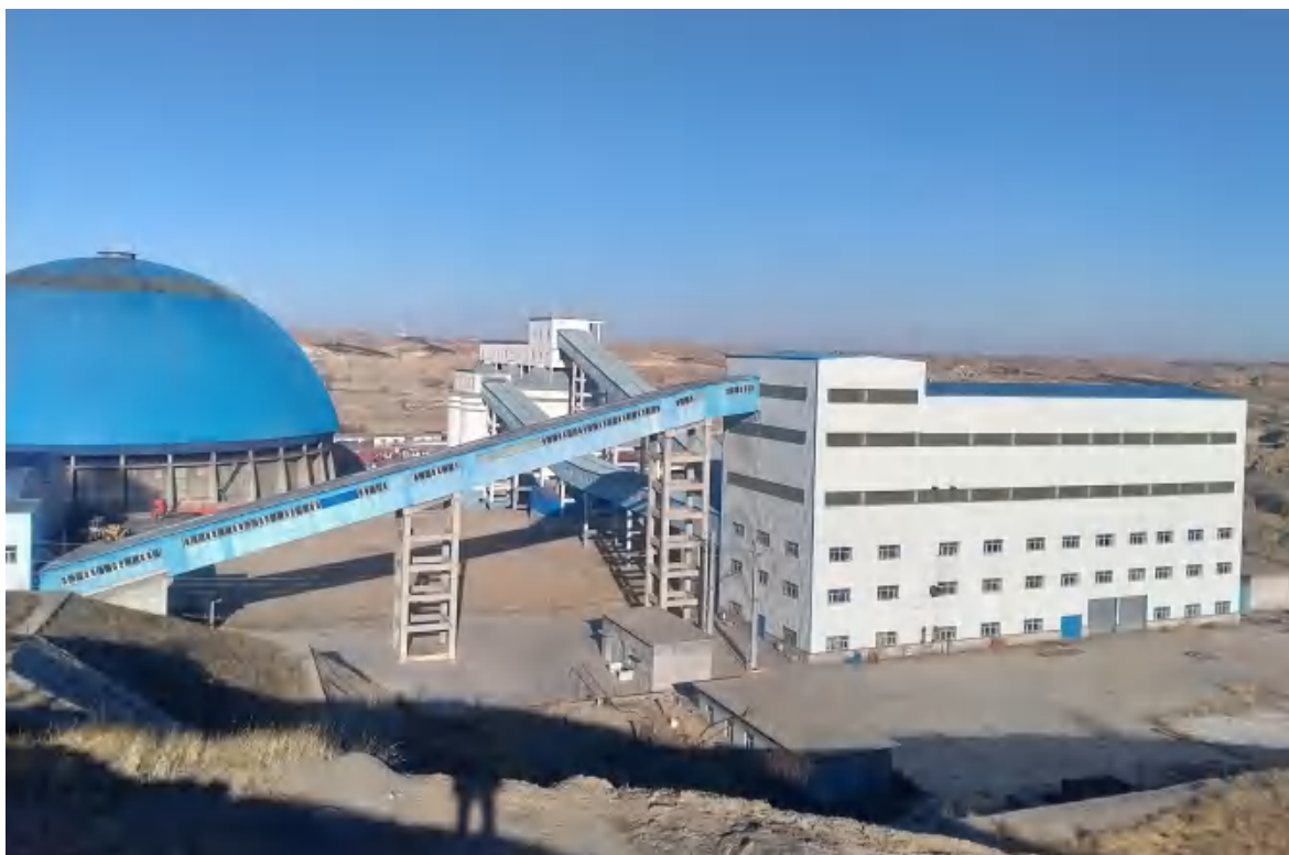
照片 1-5 皮帶输送机走廊
