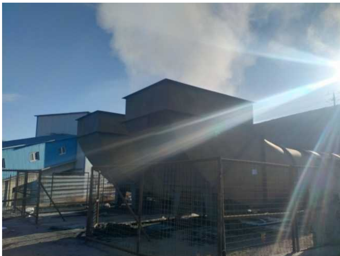
照片 1-4 风井井口
