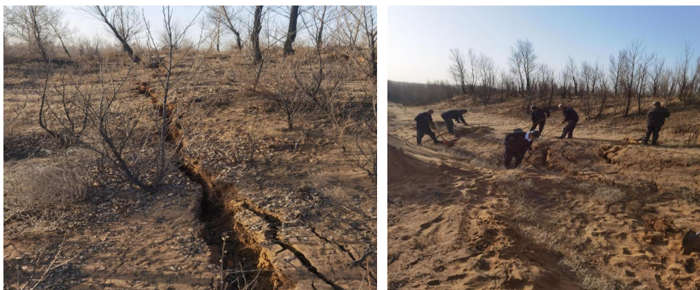
照片 3-1 采空塌陷区地裂缝及近期治理情况
