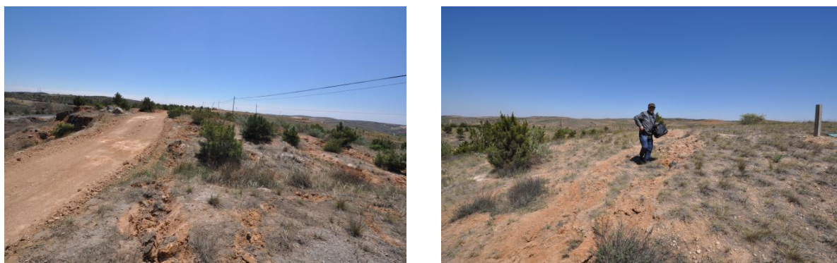
照片 2-22、2-23 宏景塔一矿已治理塌陷塌陷裂缝
