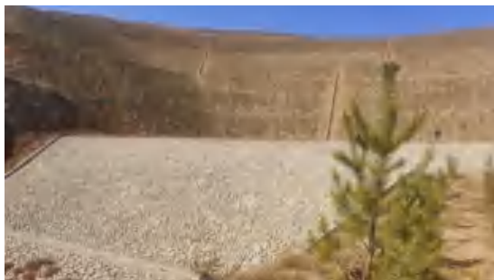
照片*- 东部边坡和挡土墙
