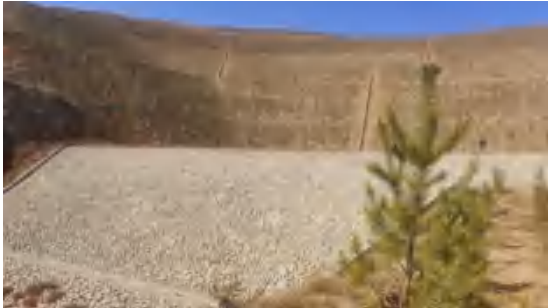
照片*-* 东部边坡和挡土墙
