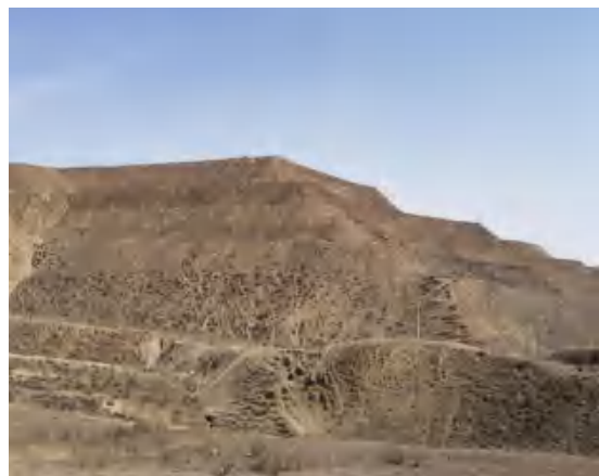
照片*-** 西外排土场边坡治理效果
