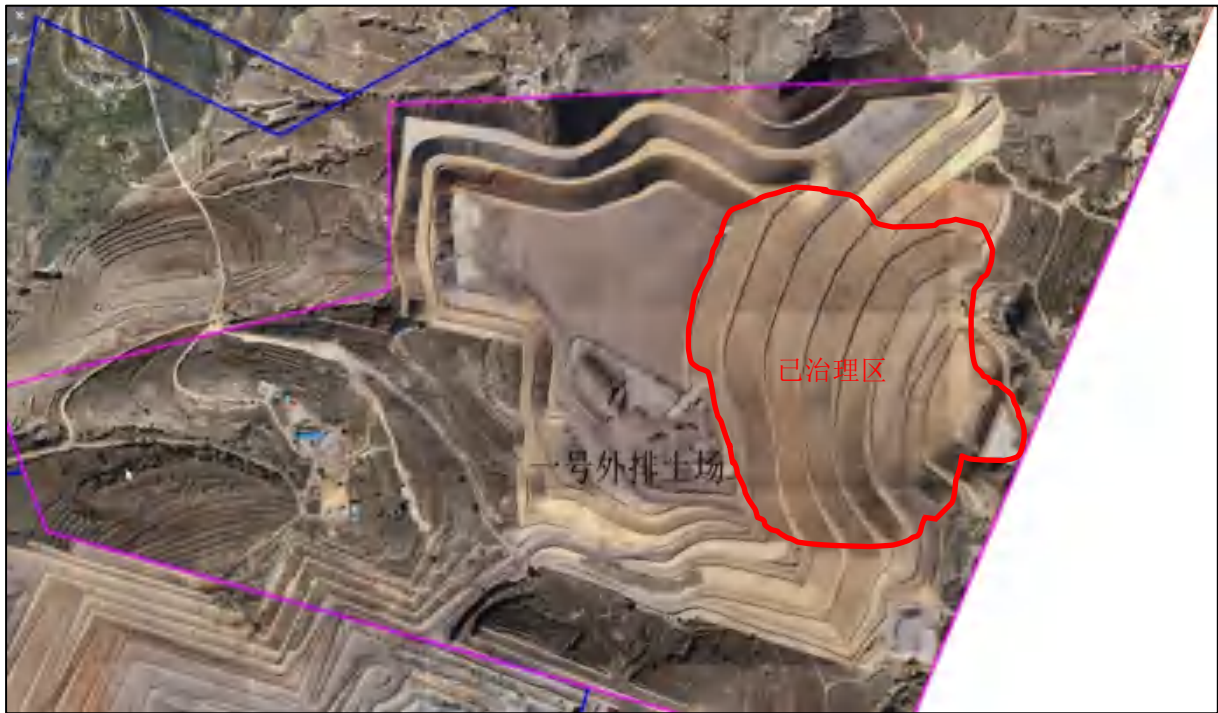
照片*-* 现状外排土场及已治理区
