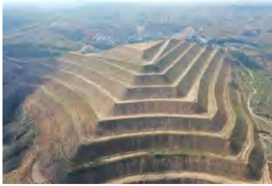
照片*-** 外排土场治理全貌
