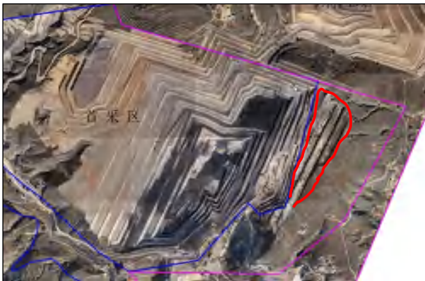
照片*- * 现状废弃剥离面
