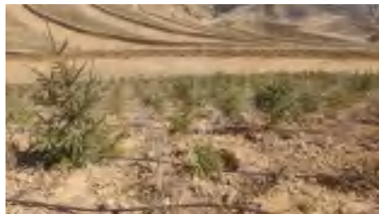
照片*- 边坡植被和平盘挡水围堰
