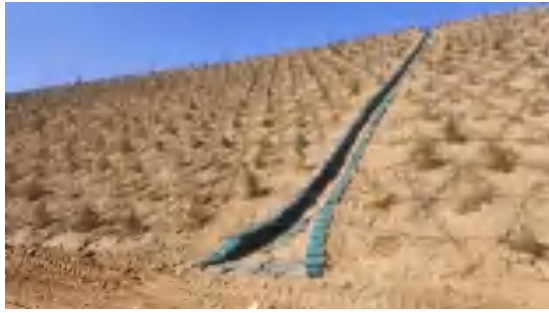
照片*-* 边坡沙柳沙障和排水沟
