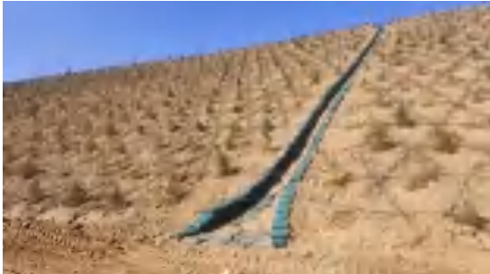
照片*-* 边坡沙柳沙障和排水沟
