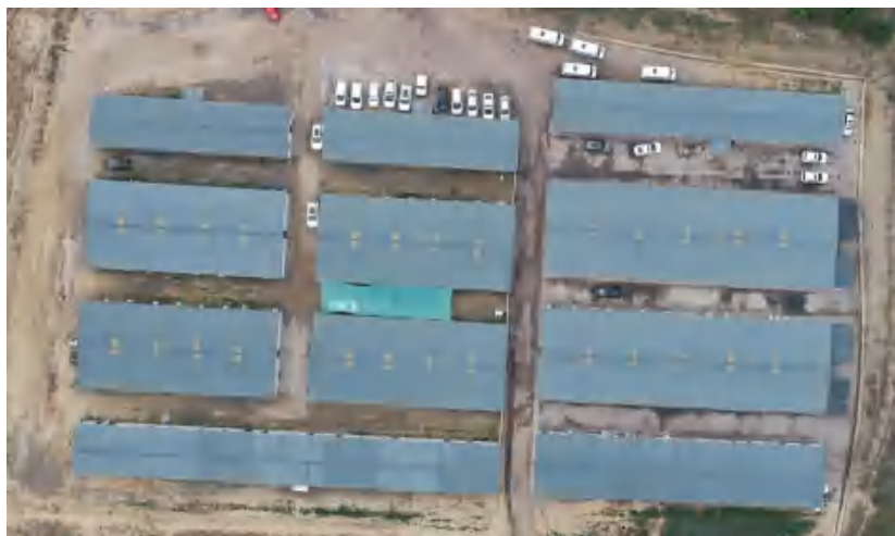
照片*-* 施工队场地
