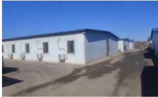
照片*-* 施工队场地
