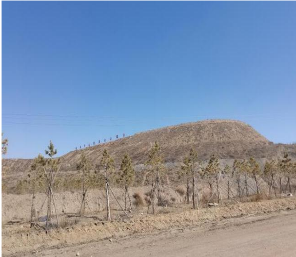
照片 3-4 完成治理外排土场
