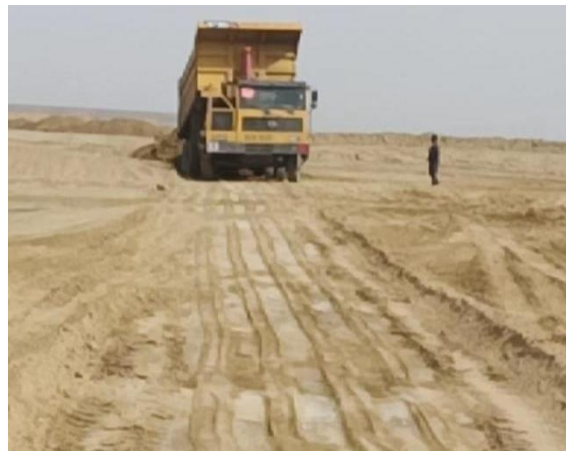
照片 3-3 内排土场 1360m 平台
