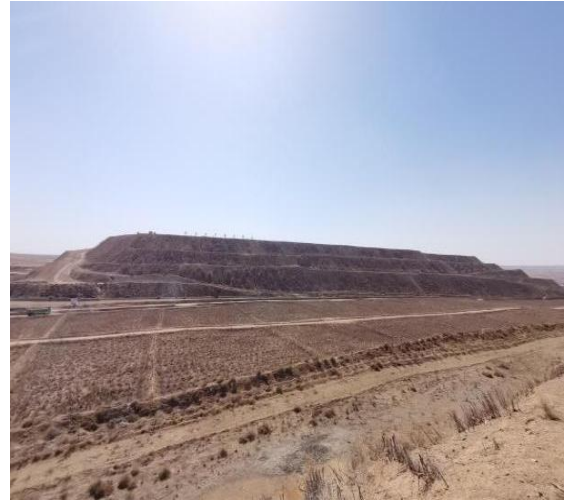
照片 3-5 完成治理外排土场
