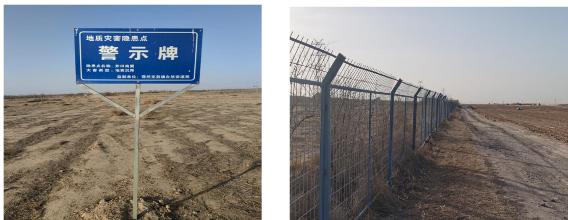
照片*-* 长城六号煤矿地裂缝回填前后的对比照片
