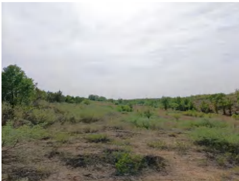
照片 2-13 塌陷裂缝治理后效果
