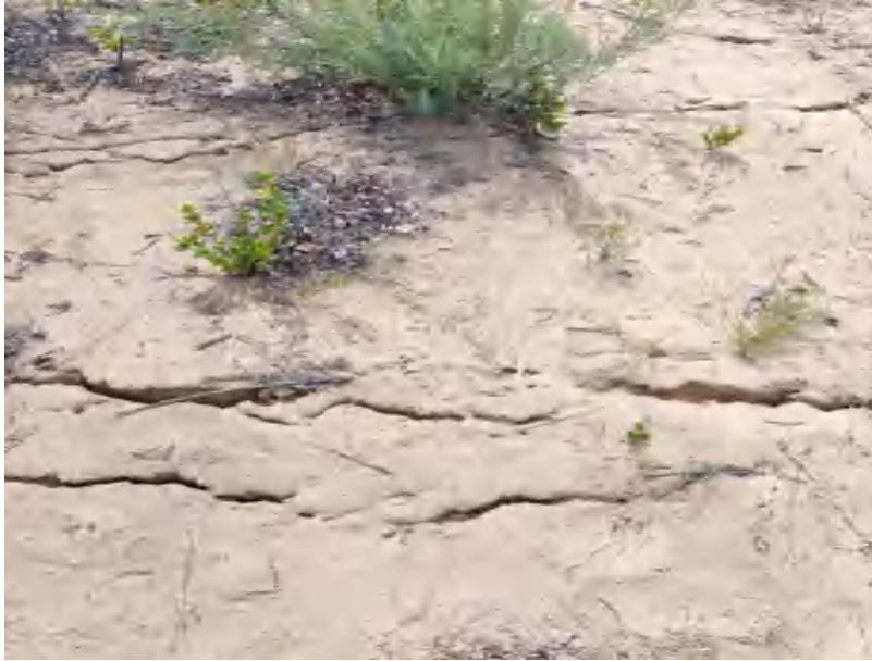
照片 3-2 综采采空区地表裂缝
