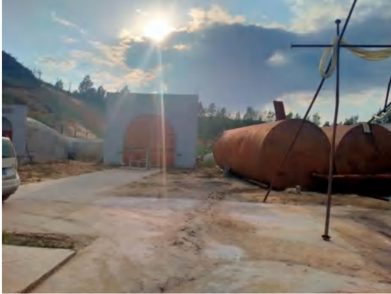
照片 1-10 二号风井工业场地
