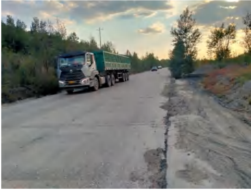
照片 1-13 进场道路
