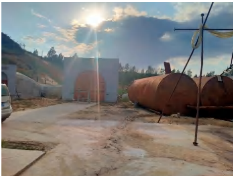
照片 1-19 二号风井工业场地
