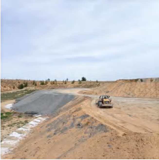
照片 1-20 排矸场平台
