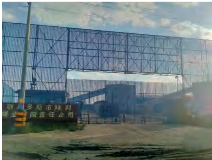
照片 2-7 隆利洗煤厂
