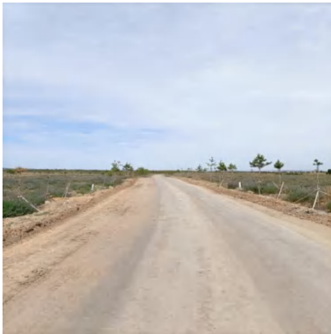
照片 2-11 排矸场道路
