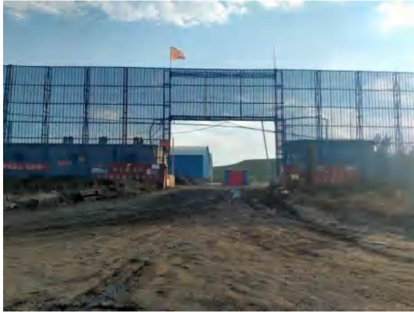
照片 2-8 隆达洗煤厂
