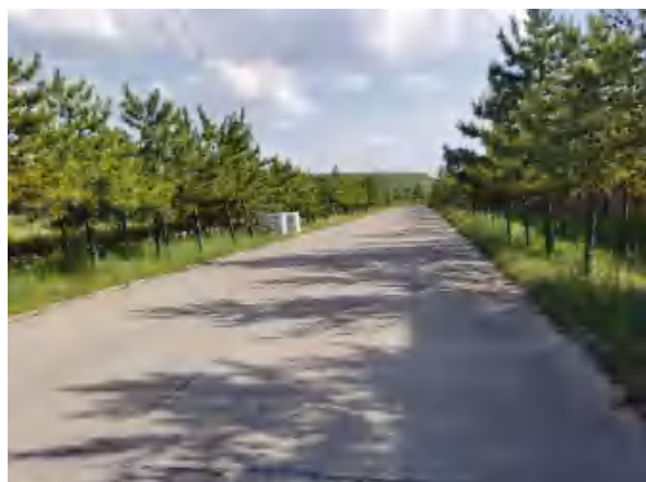
照片 1-6 进场道路
