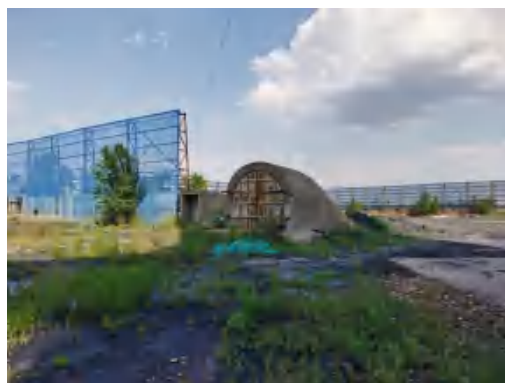
照片 1-5 回风斜井井口
