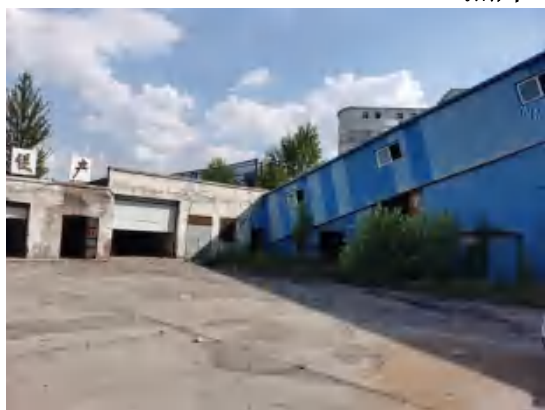
照片 1-2 主斜井井口
