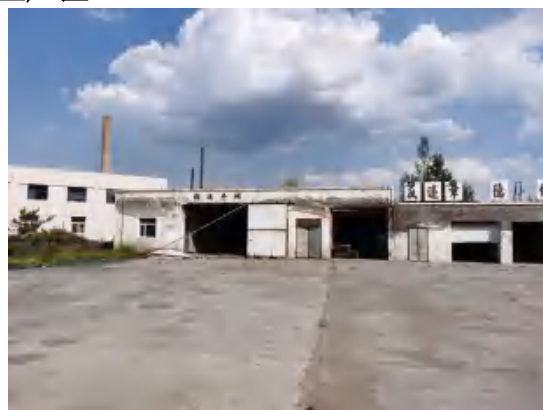
照片 1-3 副斜井井口
