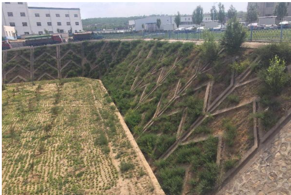
照片 2-4 工业广场不稳定边坡治理效果
