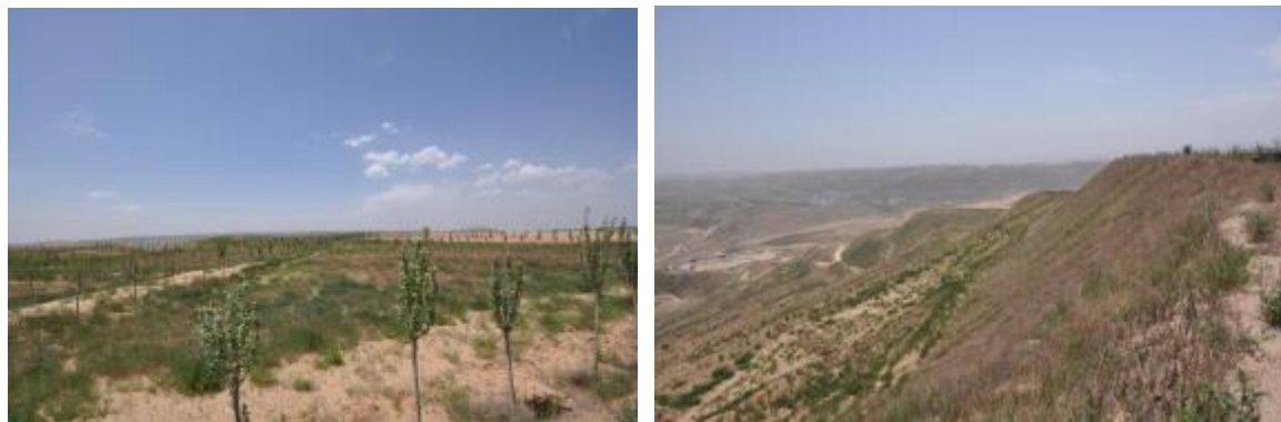
照片 2-13 已治理的魏家峁煤矿外排土场平台和边坡
