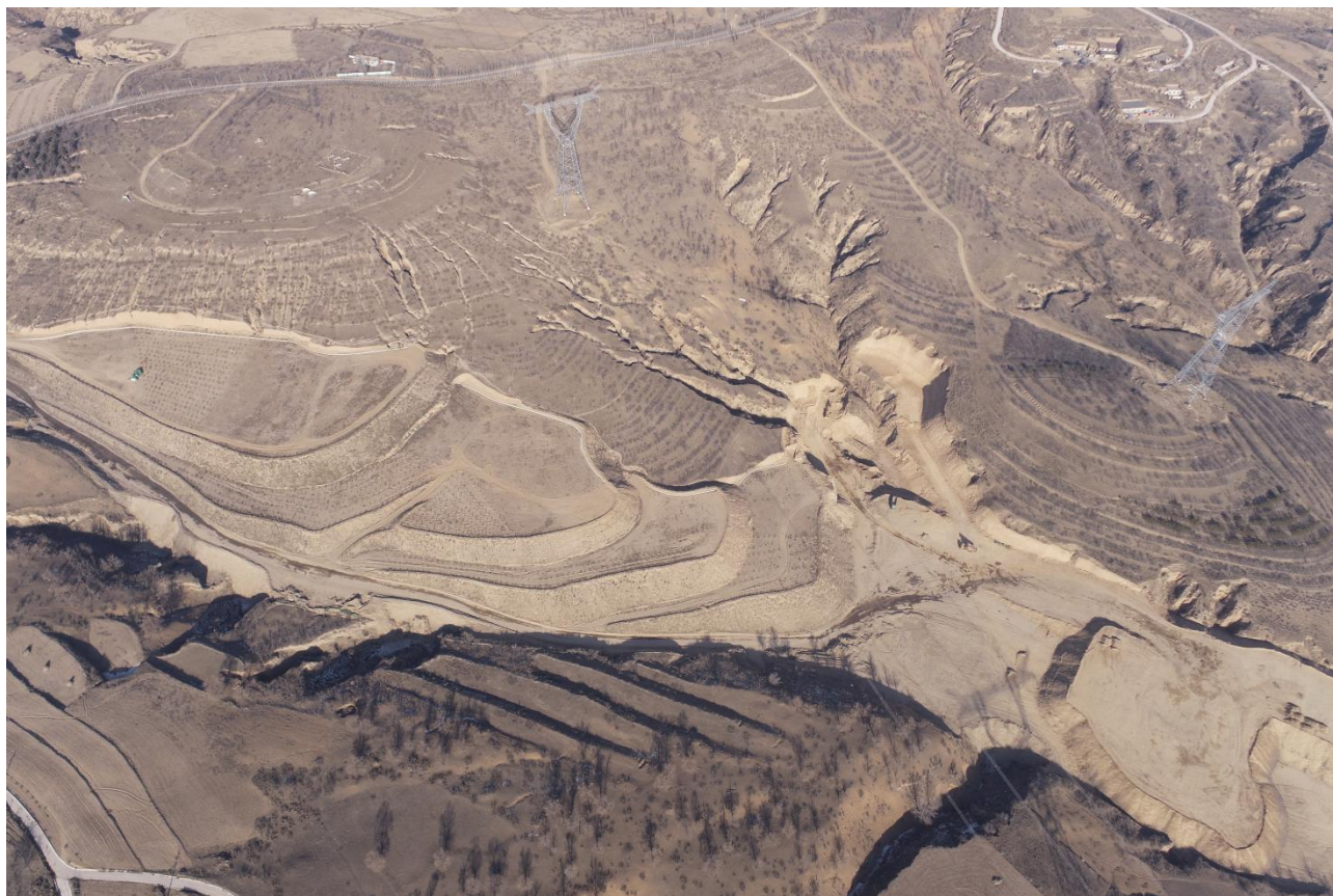
照片 1-9 排矸场现状
