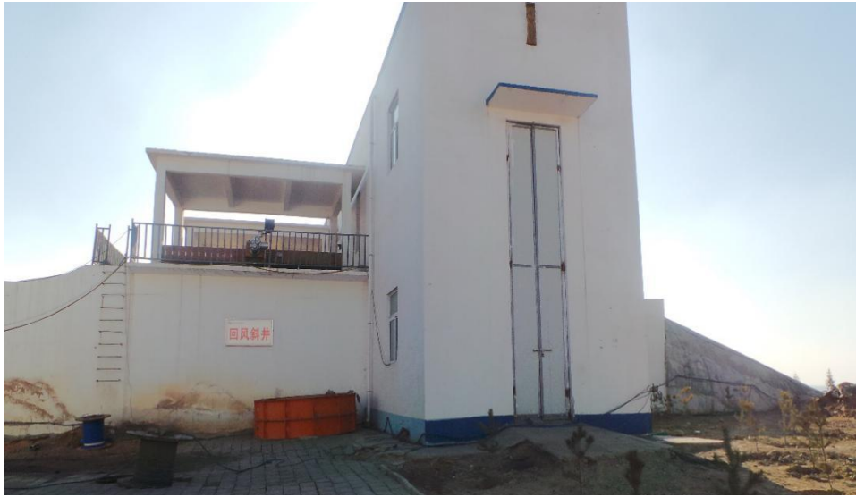
照片 1-4 风井工业场地
