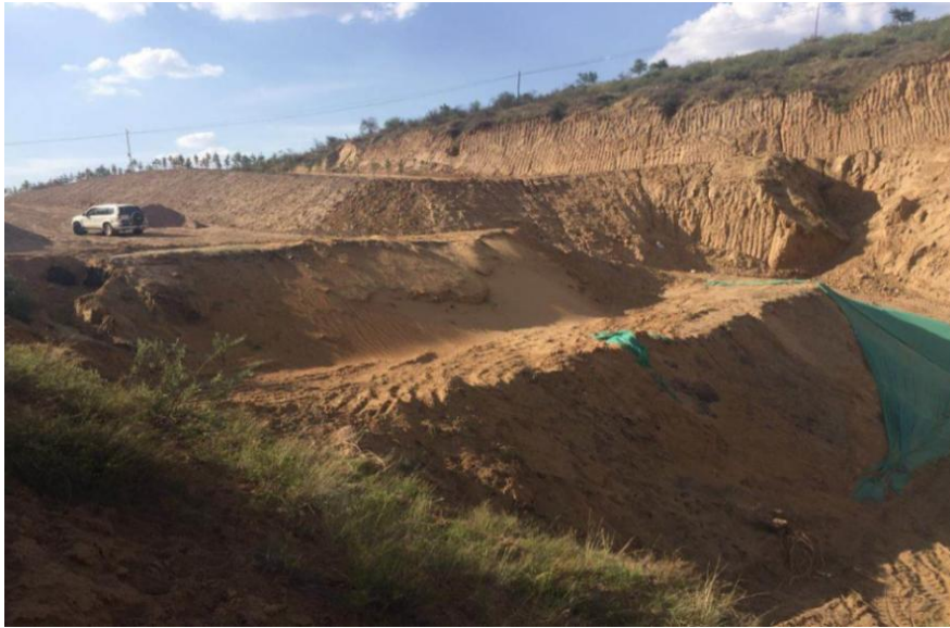
照片 1-8 矸石填沟治理现状
