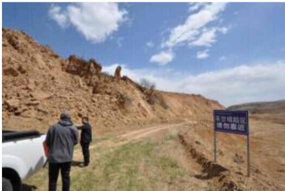
照片 2-10 塌陷区警示牌
