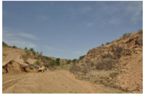
照片 2-9 正在治理塌陷区
