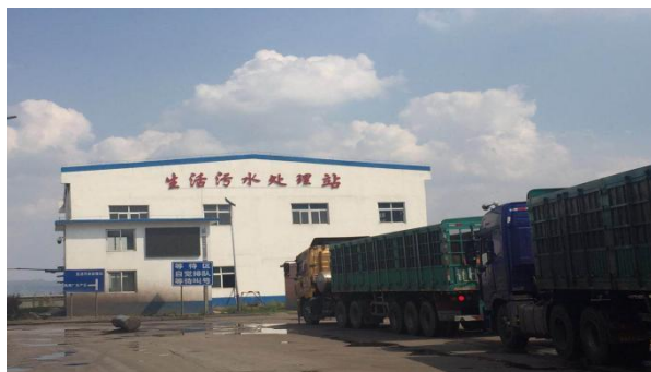
生活污水处理站
