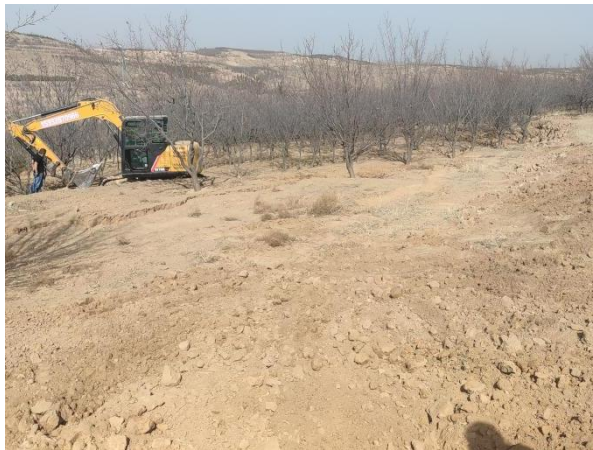
照片 1-7 地面裂缝和塌陷区进行治疗
