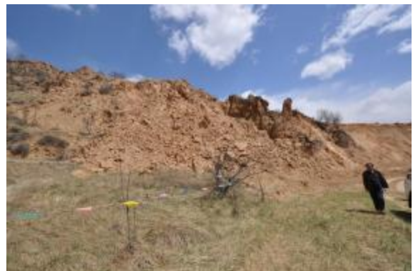
照片 2-11 塌陷区网围栏
