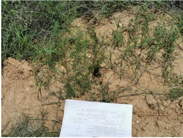
照片 2-23 较窄的地面塌陷裂缝 1
