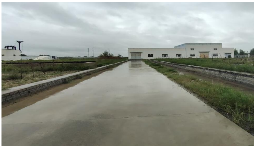
照片 1-8 矿区道路
