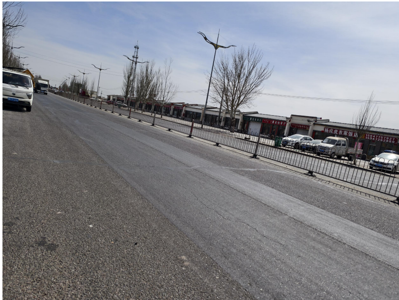
照片 2-17 国道 109 道路
