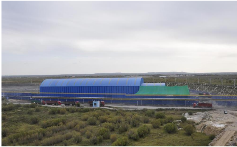
照片 1-7 临时储煤场
