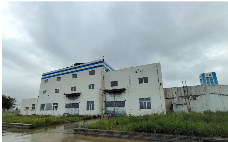
照片 1-6 风井场地
