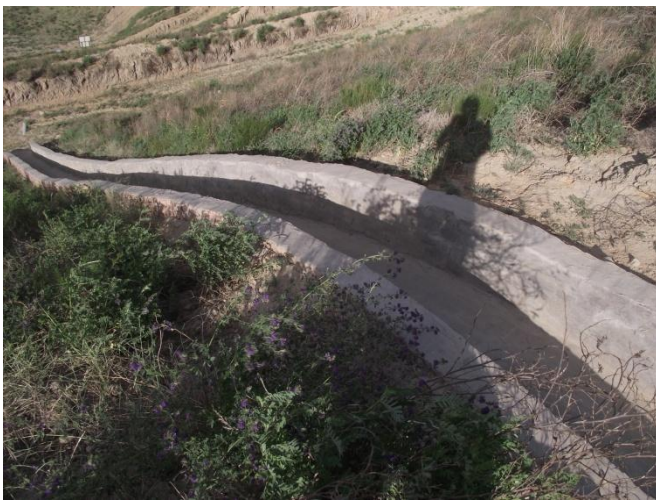
照片 2-12 浆砌石排水沟
