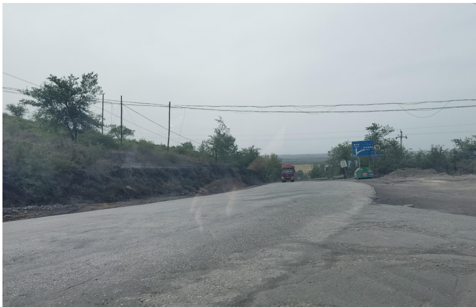
照片 1-7 矿区道路
