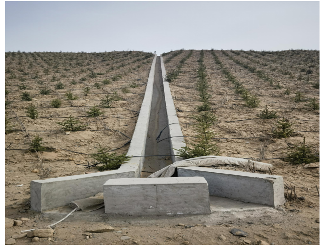
照片 2-9 边坡设置的排水渠
