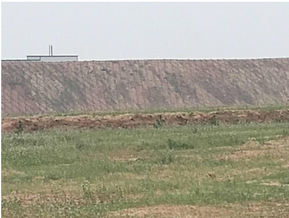
照片 2-15 排土场边坡
