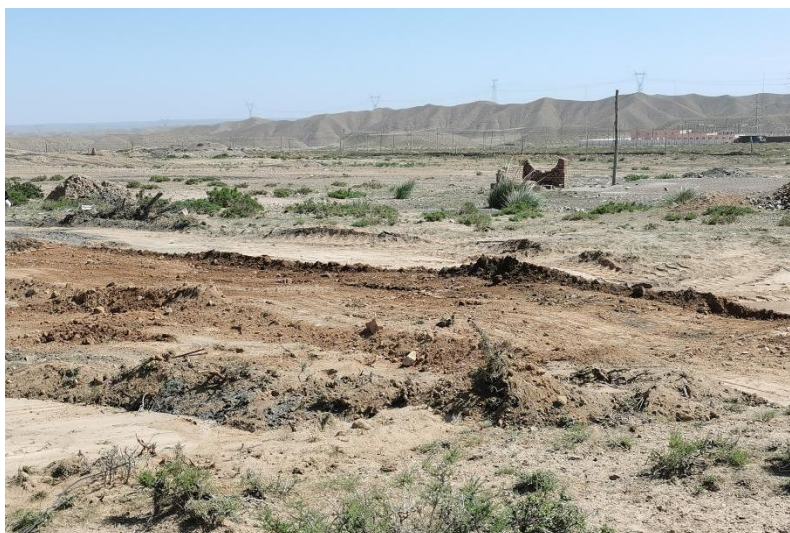
照片 1-12 采空区已回填地裂缝
