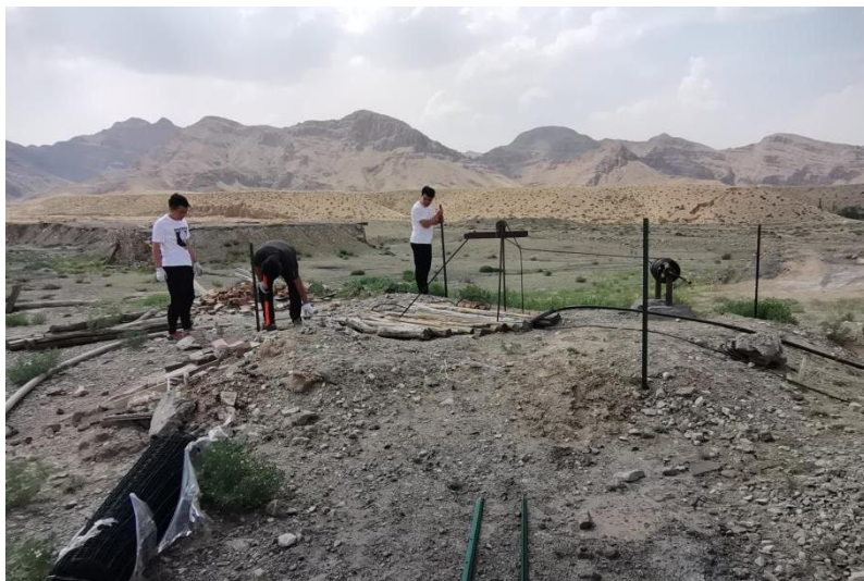
照片 2-14 废弃井口设置网围栏治理中照片
