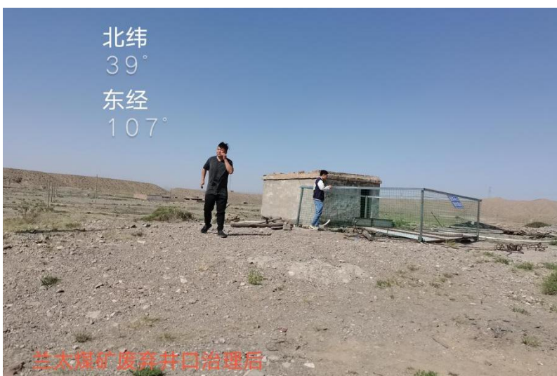
照片 2-8 废弃井口治理后照片
