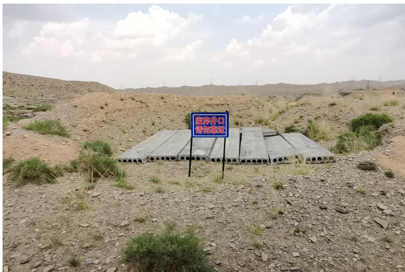
照片 1-4 废弃井口 3（井口已遮盖）
