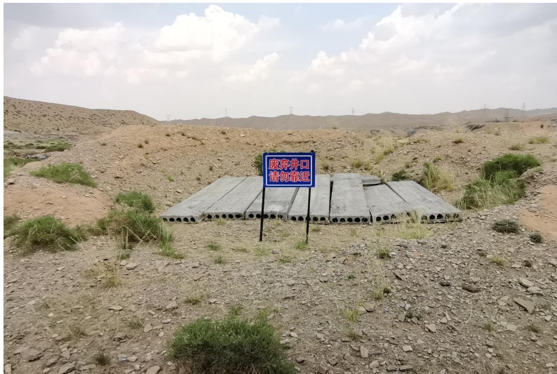
照片 2-13 废弃井口铺设盖板治理后照片
