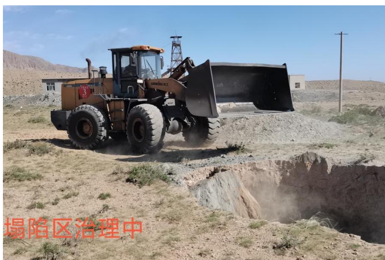
照片 2-10 地面塌陷坑治理中照片
