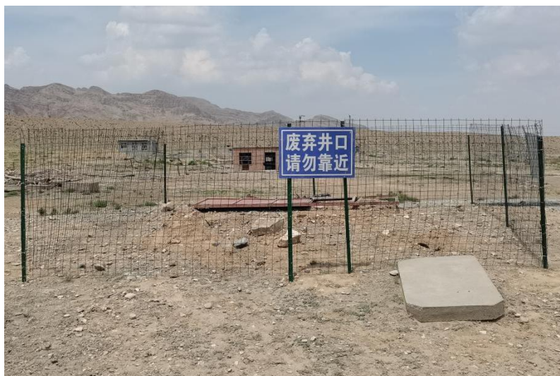
照片 2-15 废弃井口设置网围栏治理后照片
