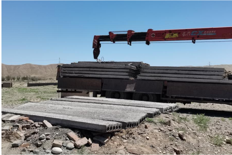
照片 2-12 废弃井口铺设盖板治理中照片
