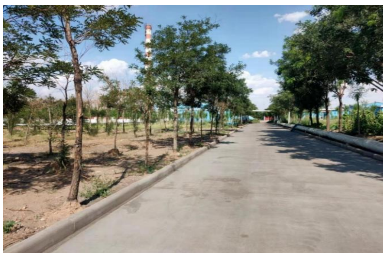
照片 1-8 矿区道路
