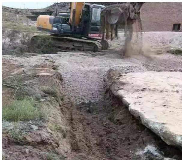
照片 2-10 都胜旧场地治理前
