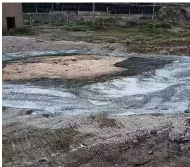
照片 2-12 都胜旧场地竖井拆除封堵后
