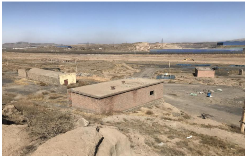
照片 1-7 都胜旧场地现状建筑
