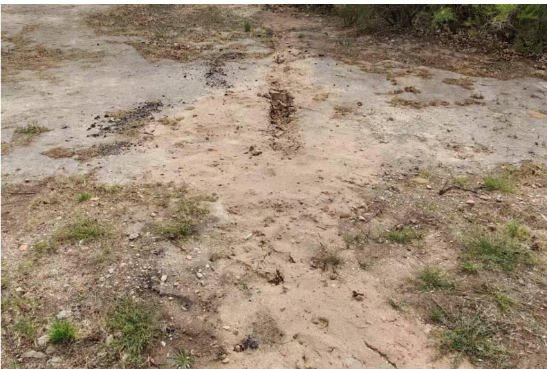
照片 2-9 采空区地裂缝治理后
