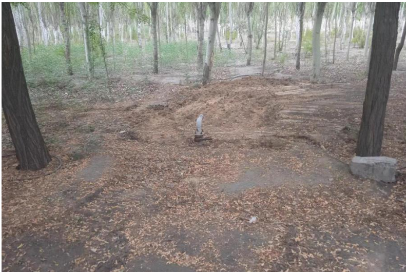
照片 2-8 采空区地裂缝治理后
