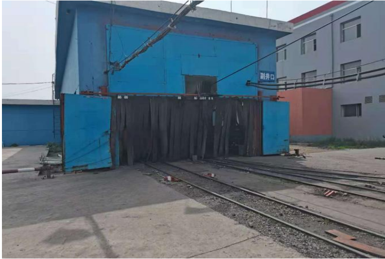
照片 1-4 工业广场副井生产区副井口
