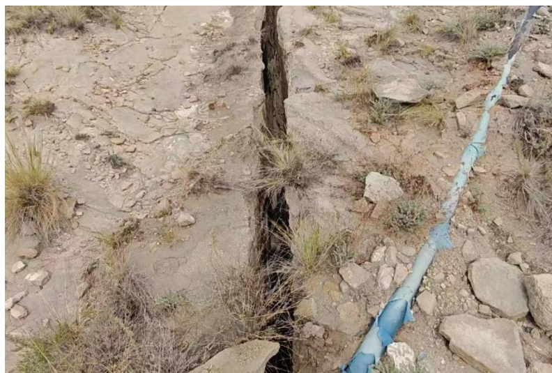
照片 1-9 采空区地裂缝治理前
