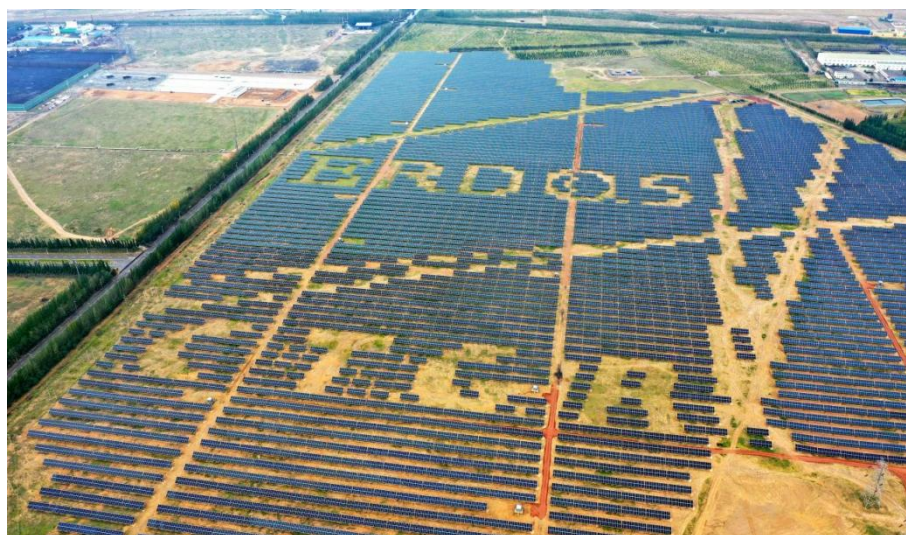
照片 2-14 采空区安装光伏设施后
