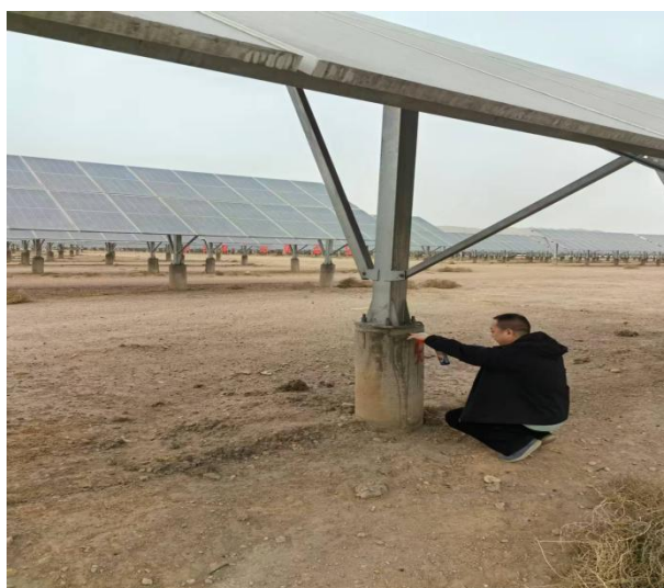
照片 2-13 采空区安装光伏设施后
