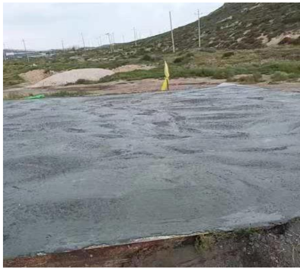
照片 1-6 都胜旧场地回填封堵后井口
