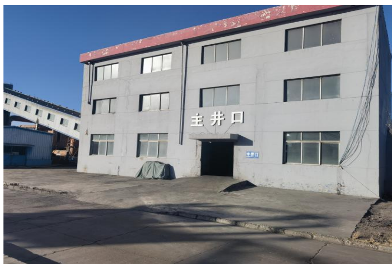
照片 1-3 工业广场主井生产区主井口
