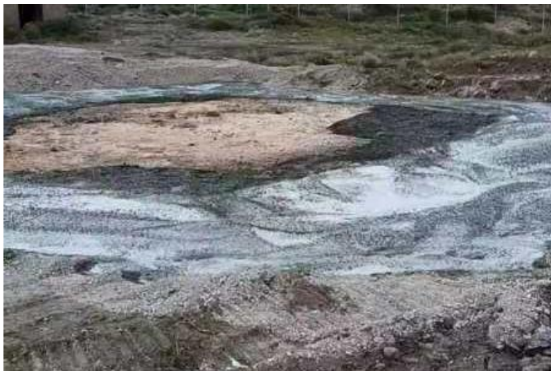
照片 0-2 都胜旧场地竖井封堵拆除治理后
