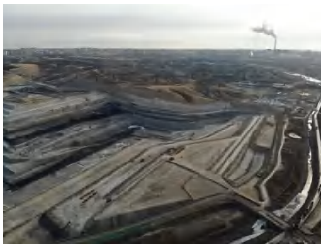
照片 1-1 现状露天采坑
