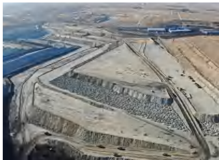
照片 1-3 二采区内排土场
