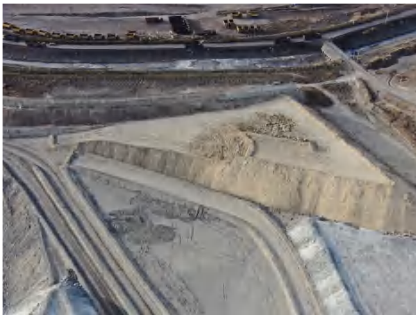
照片 1-8 二采区表土堆放场 3
