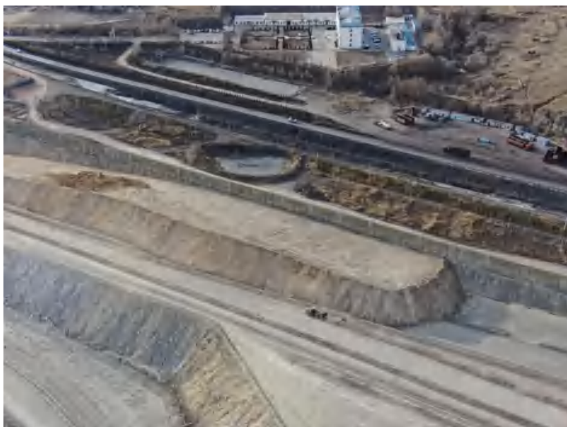
照片 1-7 二采区表土堆放场 2
