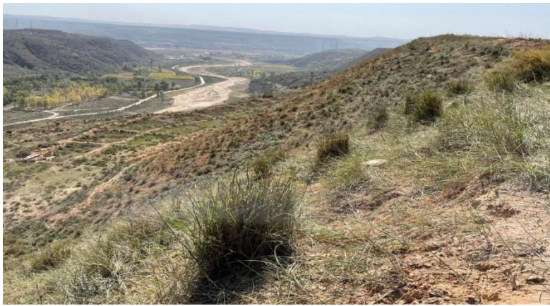
照片 2-23 排土场边坡治理效果
