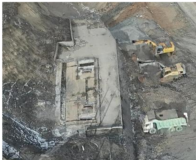
照片 1-7 废弃变电所
