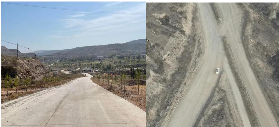
照片1-11 矿区道路
