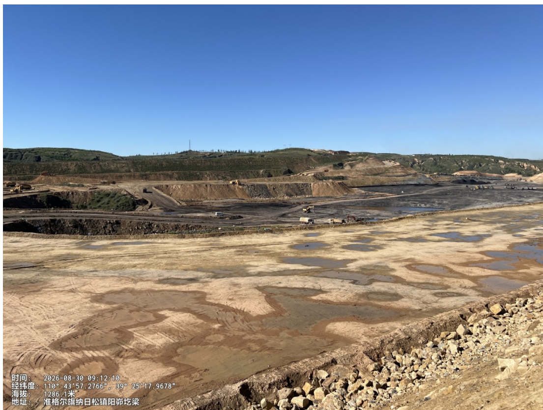
照片*-****排土平台****m, 面向西南
