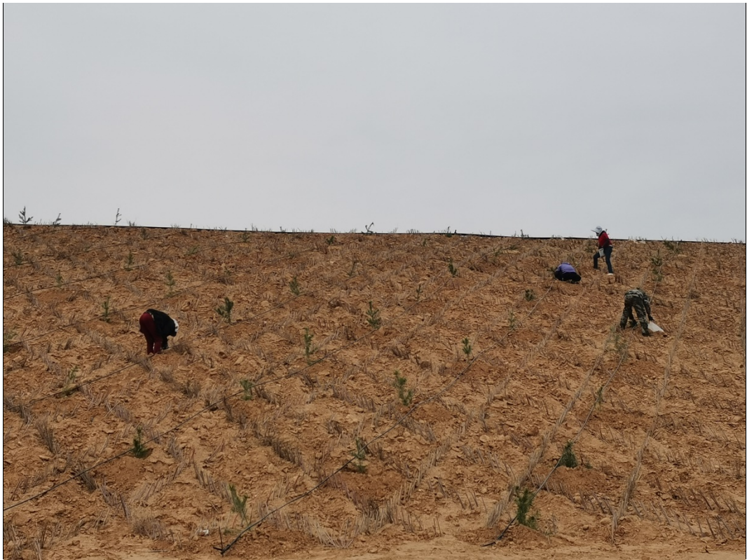
图*~****内排土场边坡治理中，柴草网格护坡，方格内种植柠条
