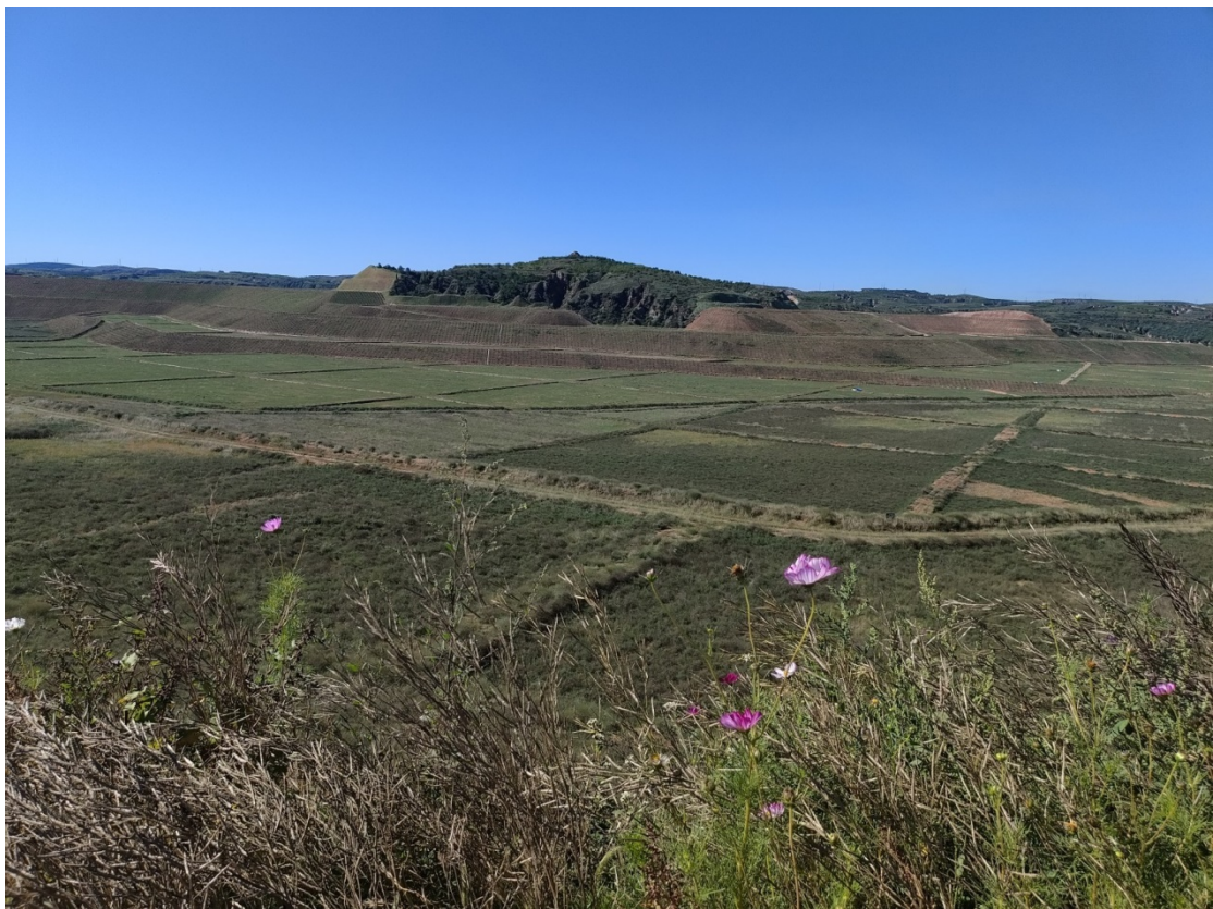
照片*-***已治理内排土场
