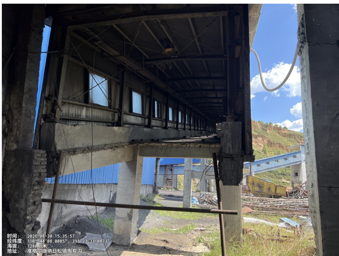
照片*_*****原二矿设施（与巷道相接）
