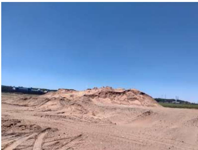
照片 1-10 表土临时堆放点
