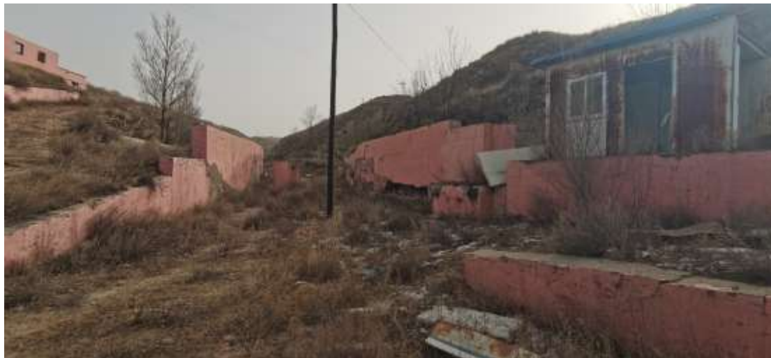
照片 1-12 原勤公煤矿工业场地
