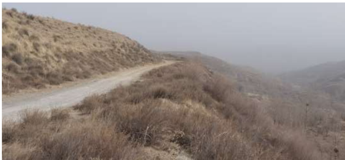
照片 1-4 2 号外排土场边坡
