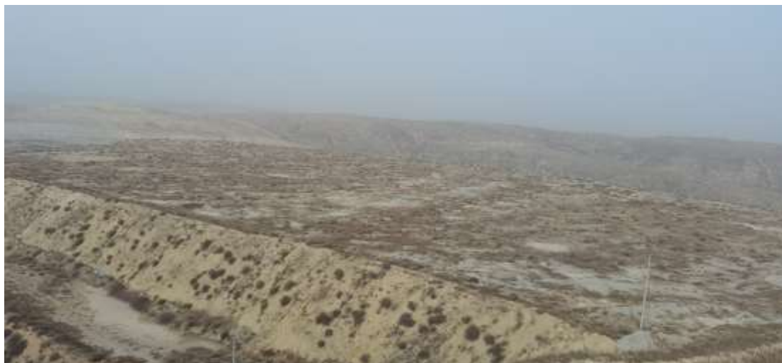
照片 1-5 3 号外排土场平台、边坡
