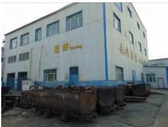
照片 1-4 西区主斜井井房
