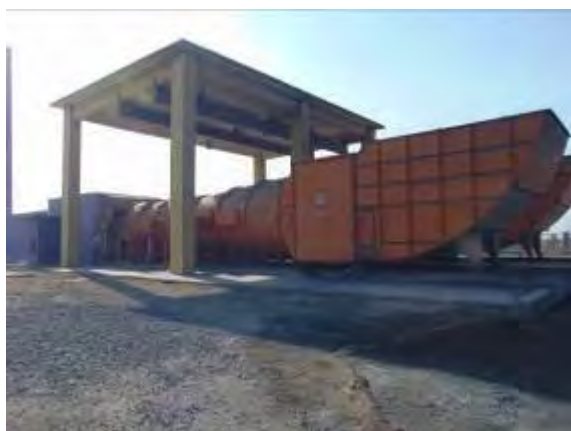
照片 1-15 东区风井
