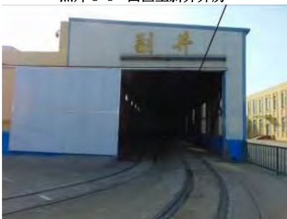
照片 1-6 西区副斜井井口房
