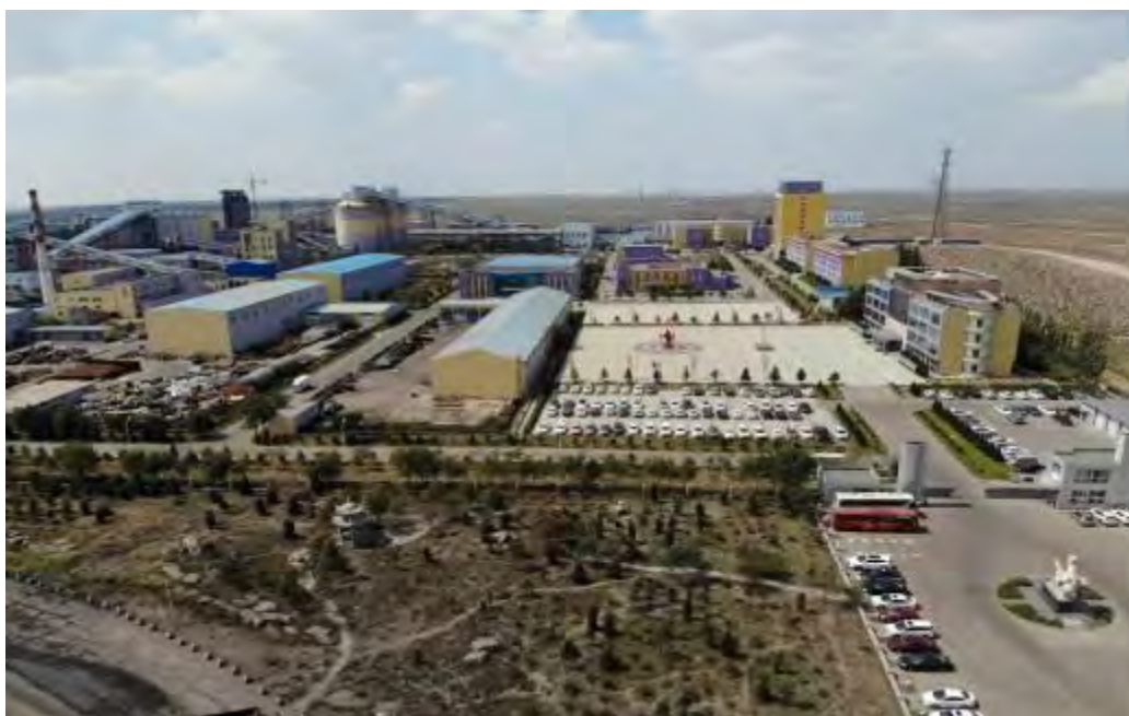
照片1-3 西区工业场地（拍摄方向由东向西）
