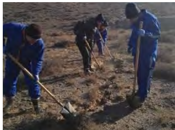
照片 2-8 地裂缝回填
