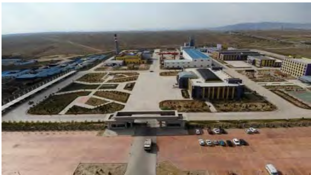
照片 1-12 东区工业场地（拍摄方向由东向西）
