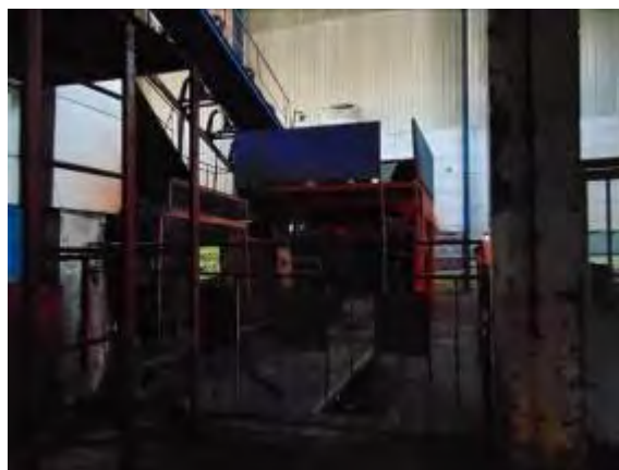
照片 1-5 西区主斜井井口
