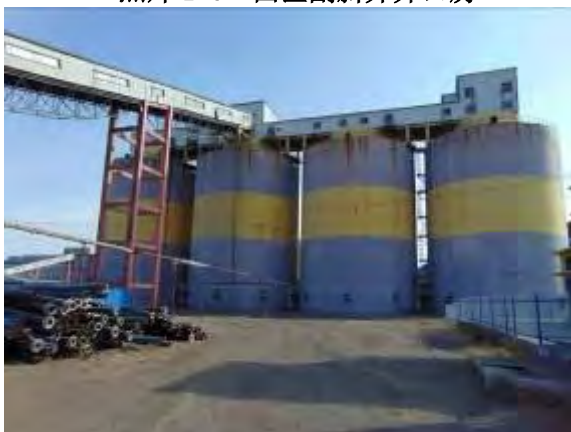
照片 1-8 西区储煤仓
