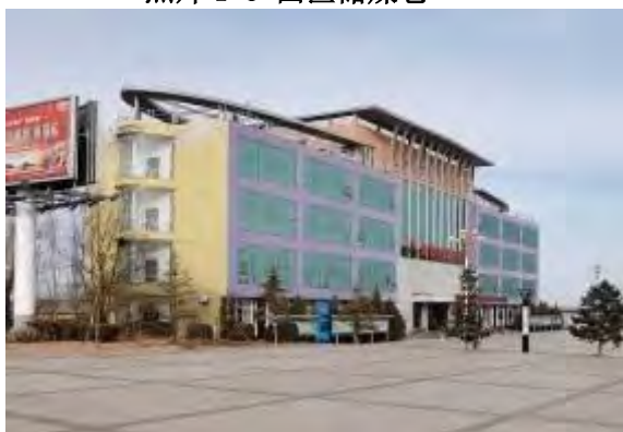
照片 1-10 西区办公楼
