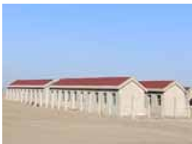
照片 1-2 临时办公生活区
