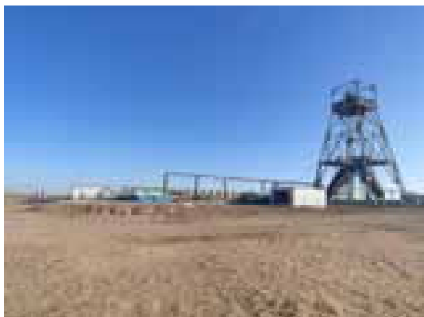
照片 1-3 正在施工的主井
