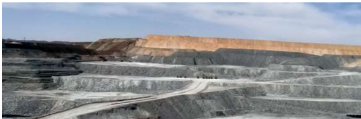
照片 3-5 三采区内排土场跟进边坡
