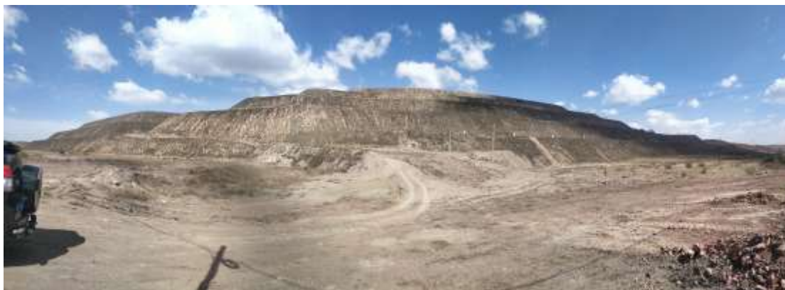
照片 1-7 一号外排土场边坡
