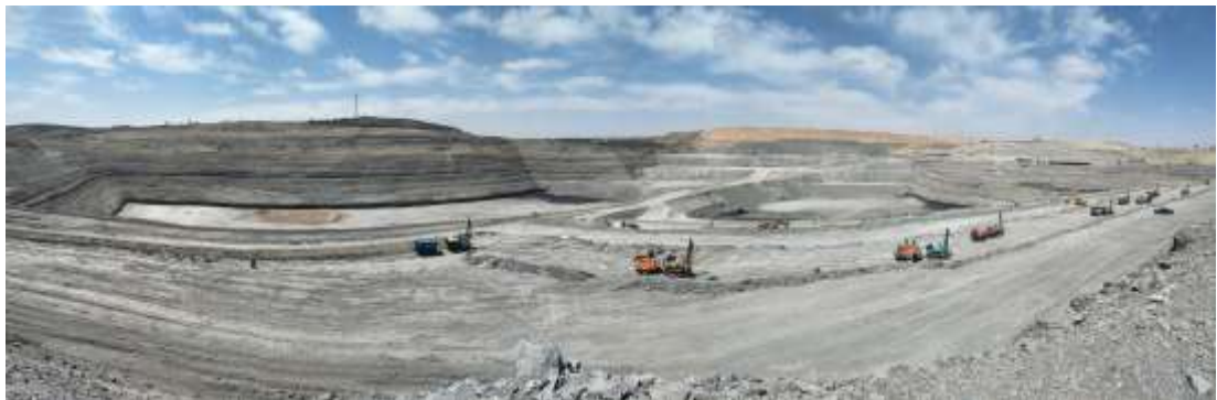
照片 1-4 三采区露天采坑和排土场全景
