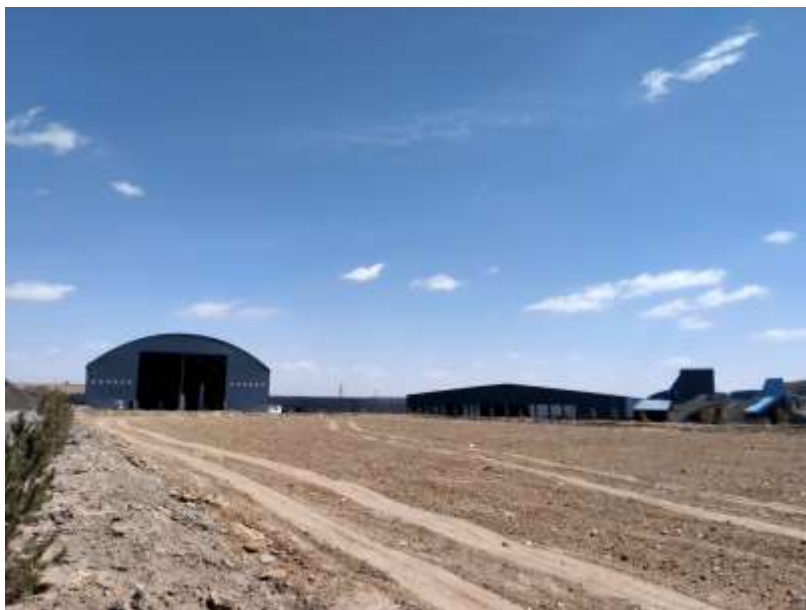
照片 1-16 四采区储煤场
