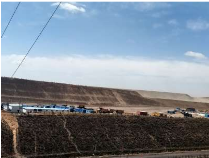
照片 1-18 维修中心
