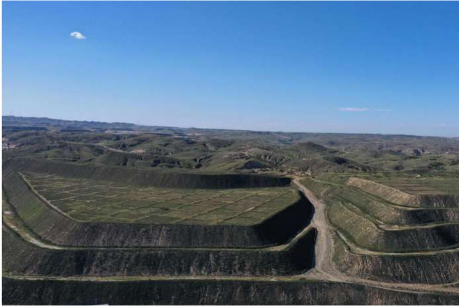
照片 2-6 已治理排土场边坡
