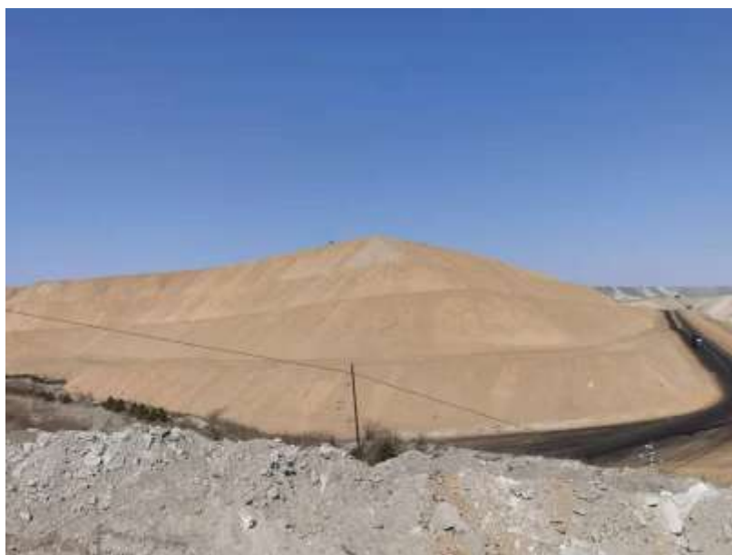
照片 1-21 五号外排土场现状
