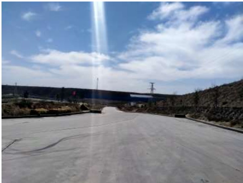
照片 1-19 进场道路
