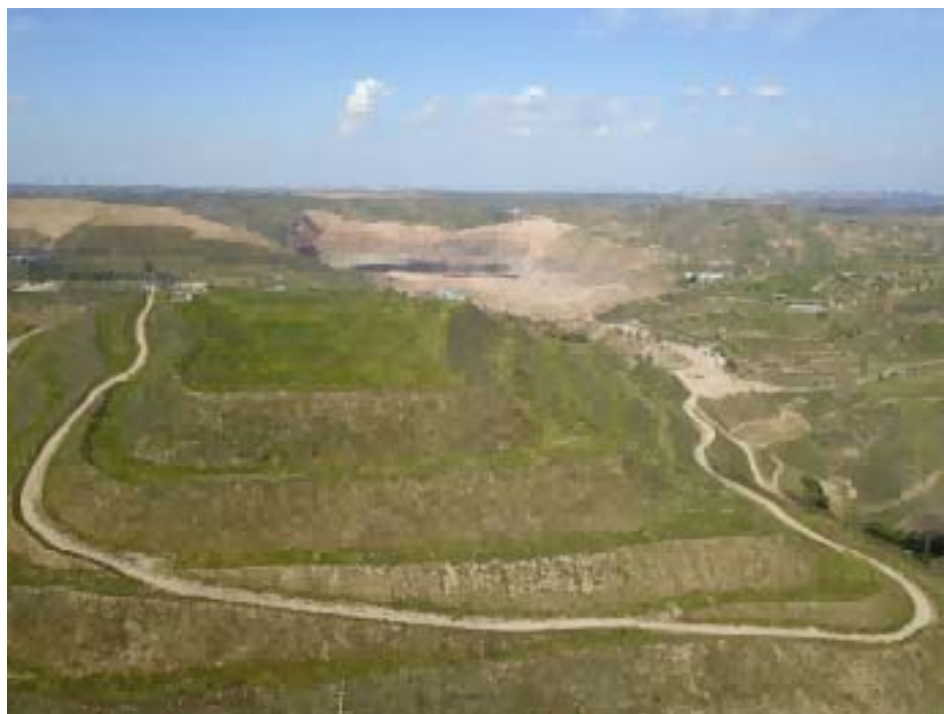
图 2.6-7 金正泰煤矿 2 号排土场治理图
