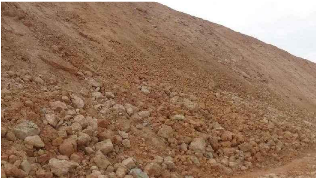
照片 2.6-5 治理前排土场边坡
