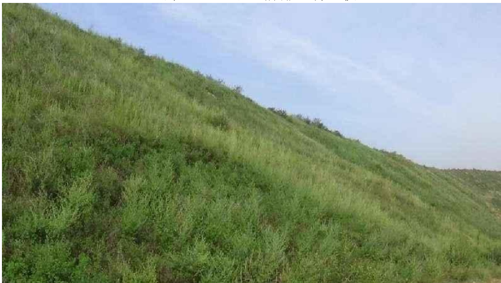
照片 2.6-6 治理后排土场边坡
