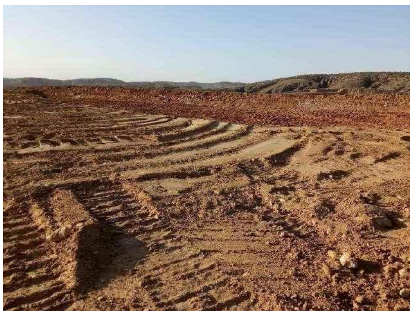
照片 2.6-1 治理前 1340m 外排土场
