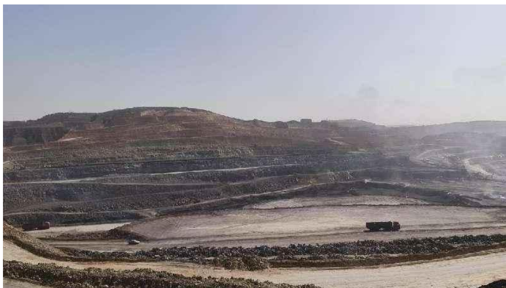
照片 3.2-2 露天采场东部边坡
