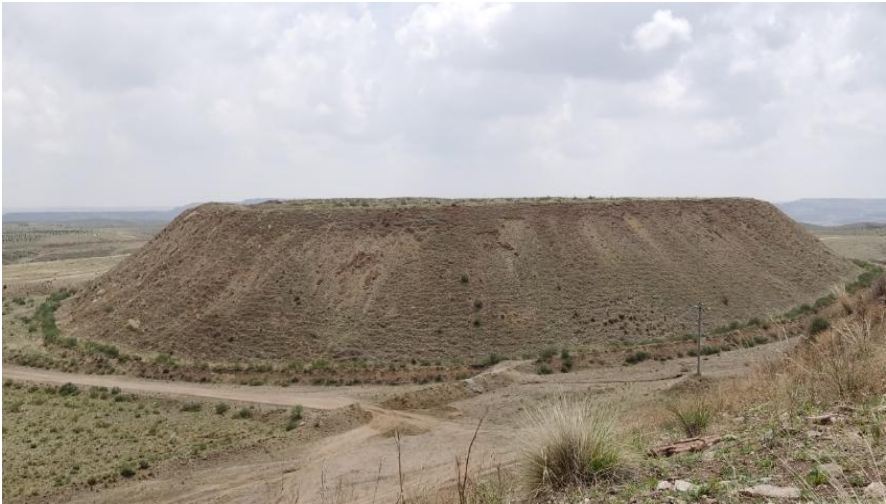
照片*-* 外排土场边坡
