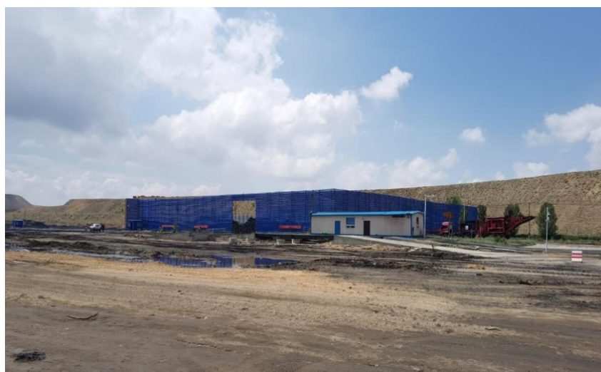
照片*-* 工业场地（储煤场）
