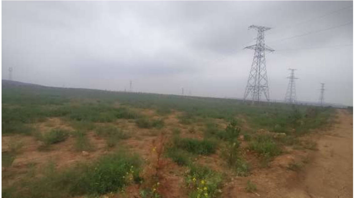
照片 1-7 内排土场已治理 1345\text{m} 标高平台
