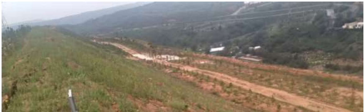
照片 1-8 内排土场已治理 1345 过度到 1330\text{m} 边坡
