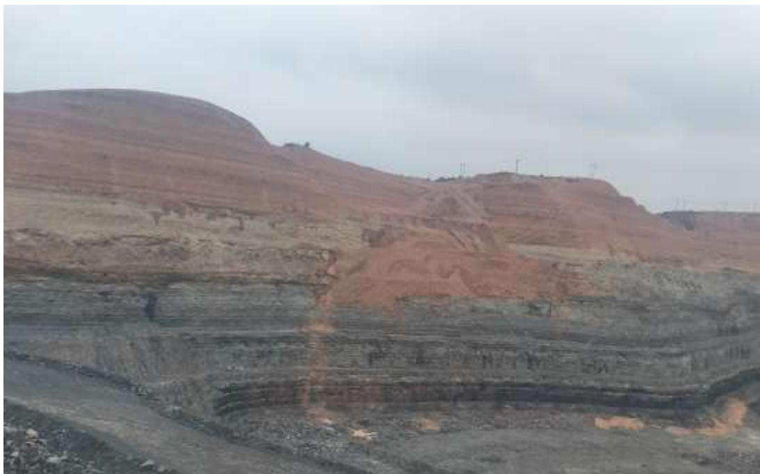
照片 3-1 露天采坑东南部边帮滑坡（治理前）
