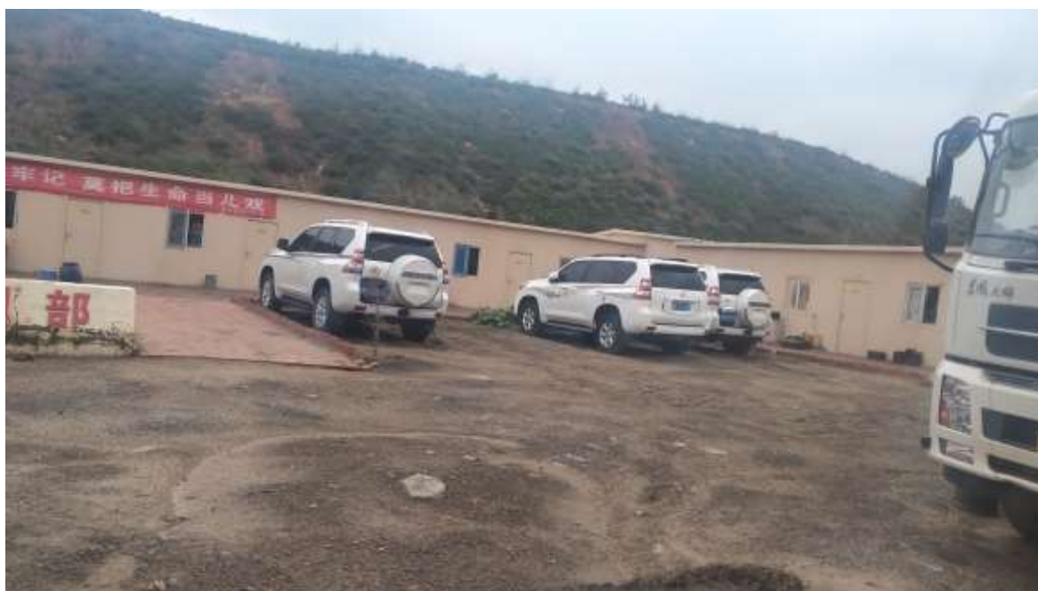
照片 3-8 爆破队生活区北部边坡存在滑坡隐患
