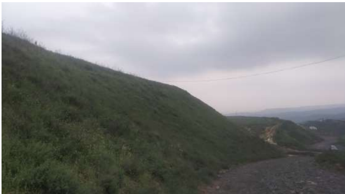
照片 1-6 外排土场边坡
