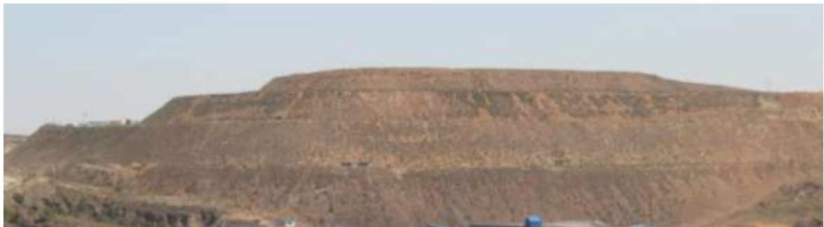
照片 3-6 外排土场排土边坡及排土整体情况
