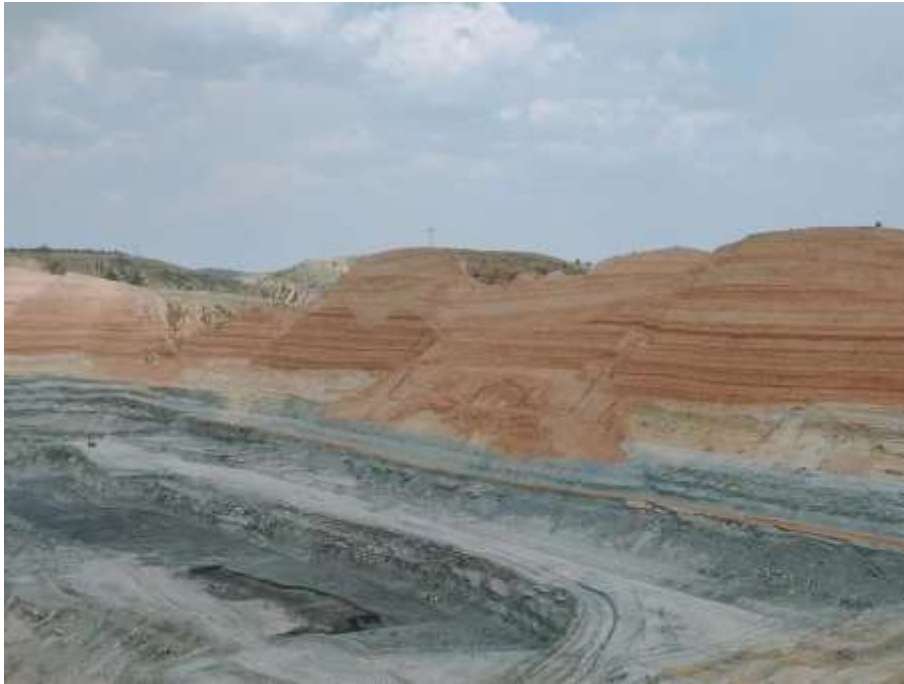
照片 3-3 露天采坑整体边帮较规整
