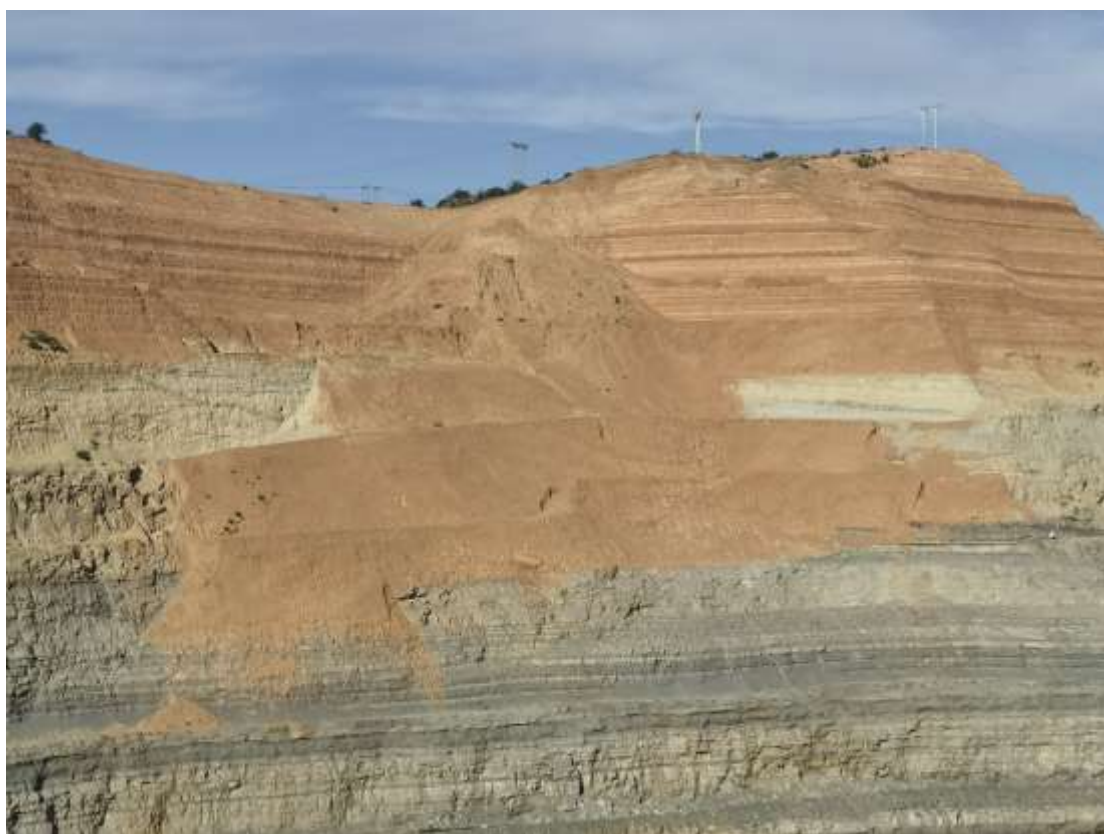
照片 3-2 露天采坑东南部边帮滑坡（治理后）
