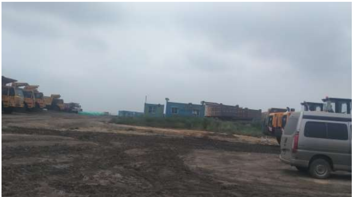
照片 1-2 施工队生活区
