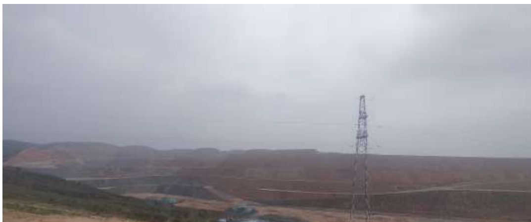
照片 3-4 内排土场边坡
