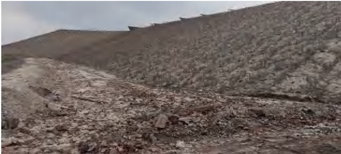
照片 3-1 排土场边坡
