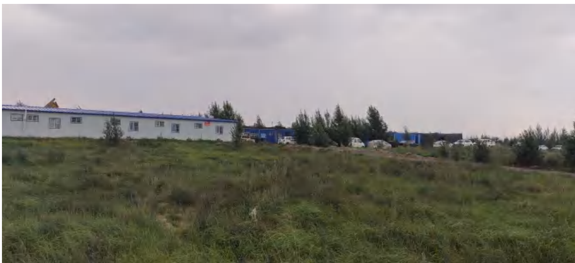
照片 1-5 施工队生活区
