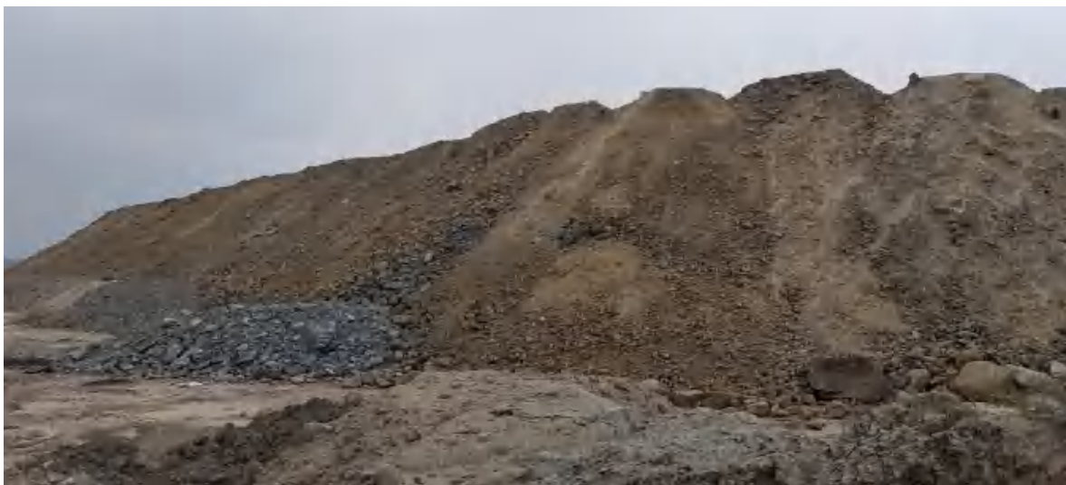
照片 1-4 表土堆放场
