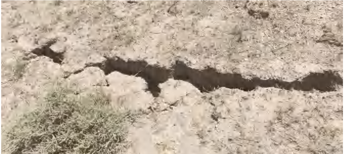
照片 3-1 地面塌陷伴生裂缝
