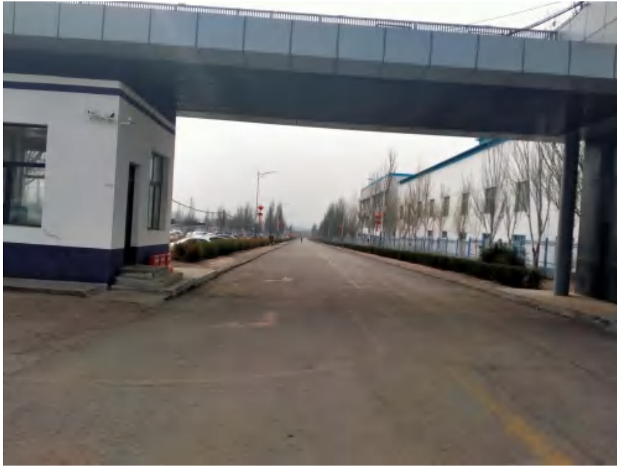
照片 1-4 进场道路
