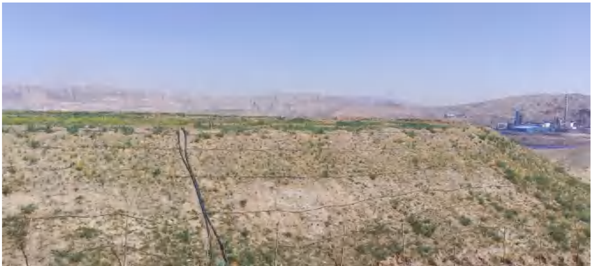
照片 1-7 排矸场边坡
