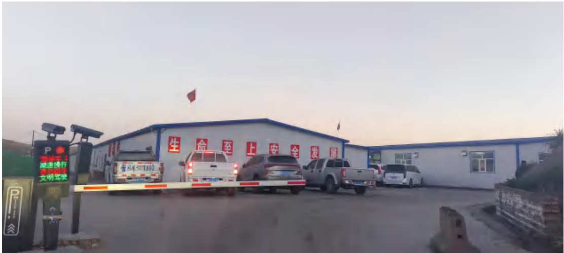
照片 1-9 施工队生活区
