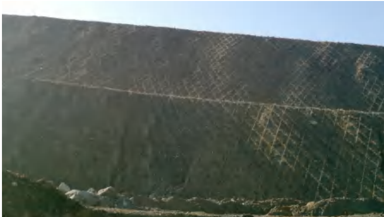
照片 2-4 南外排土场已治理边坡
