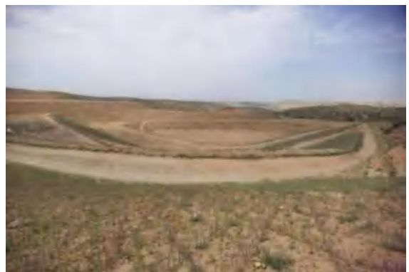
照片 1-4-3 外排土场
