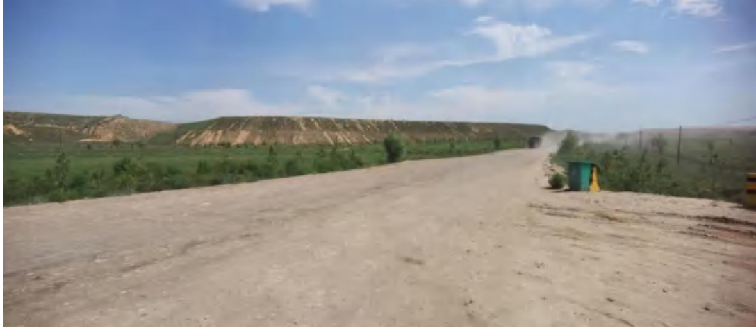
照片 3-2-9 矿区道路
