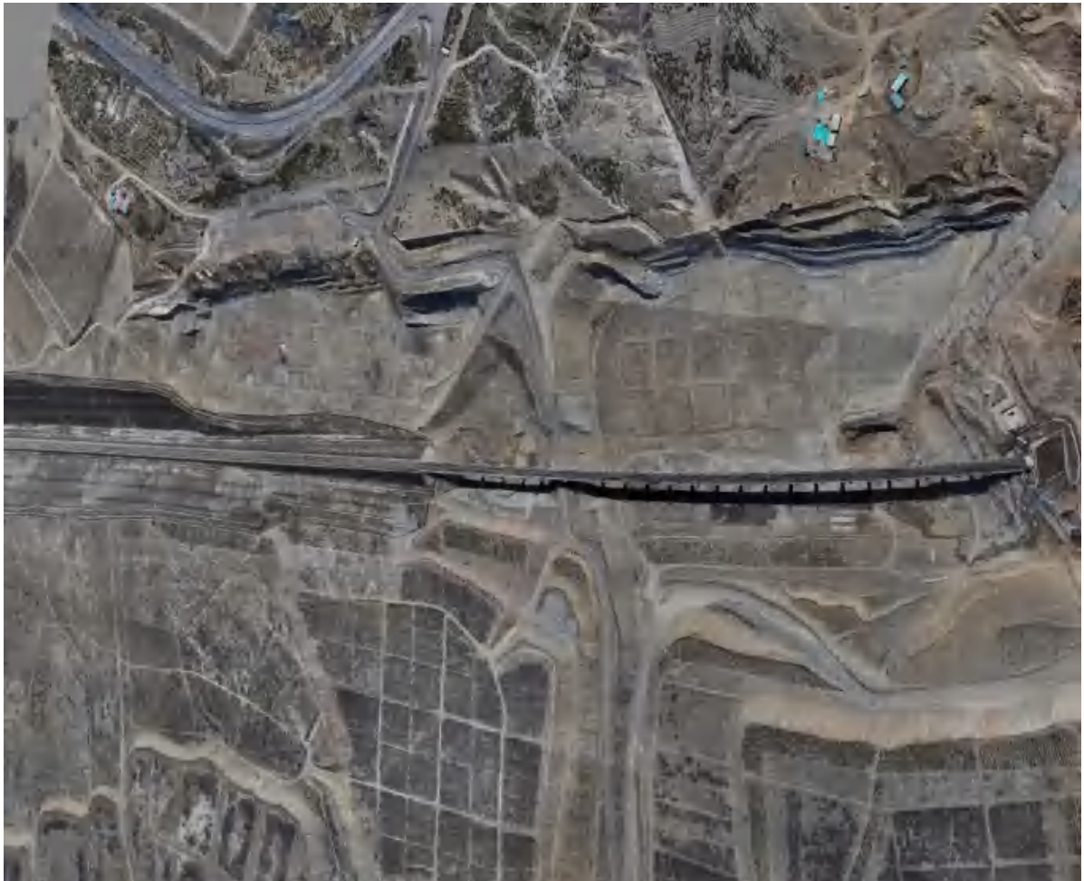
照片 1-4-2 铁路南侧两侧现状
