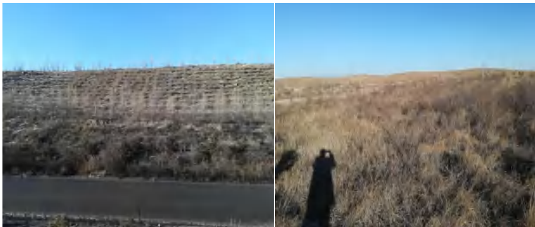
照片 2-6-4 排土场治理
