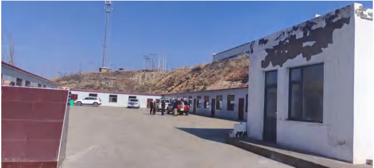
照片 1-4-9 施工单位驻地
